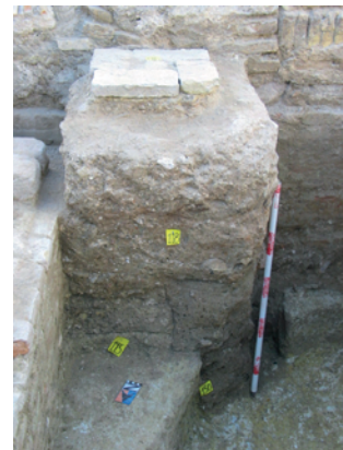
Lámina III. Detalle de cimentación de pilar o columna del pórtico oeste del patio del siglo XIX. Fase V.
