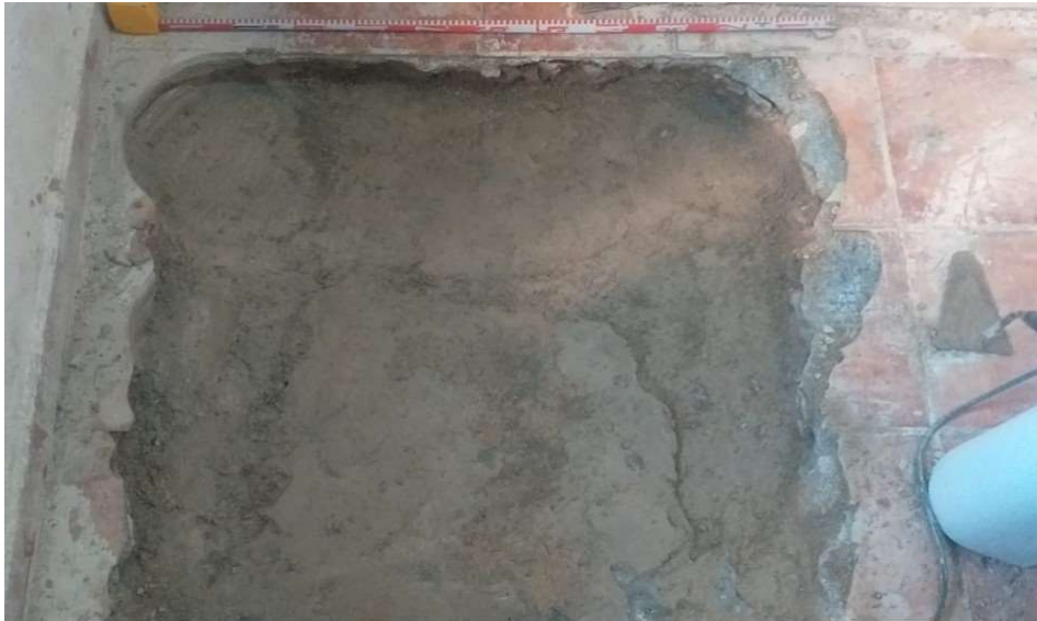
Fig. 3 Detalle del nivel relleno bajo la solería del baño.
