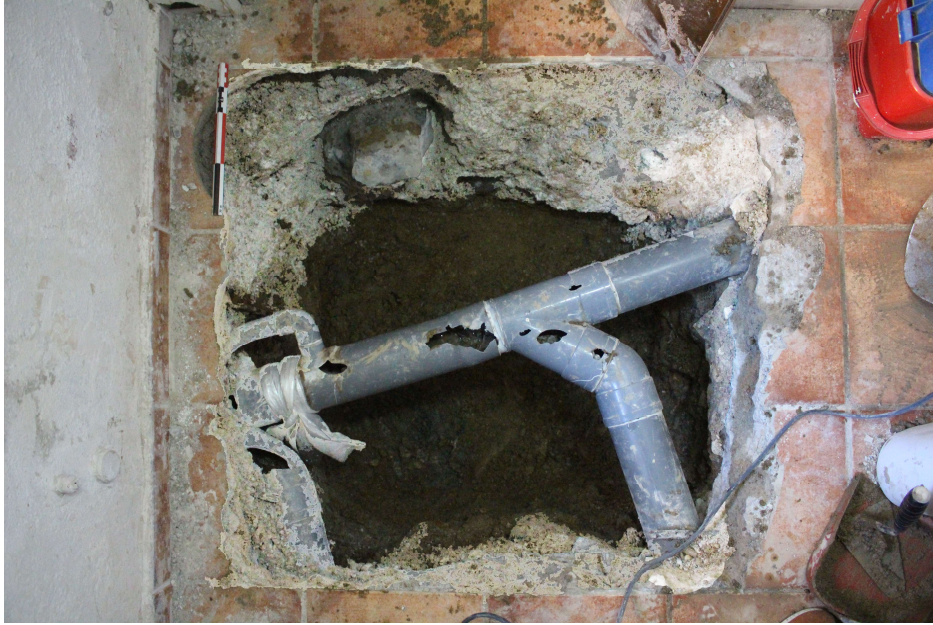
Fig. 4 Detalle de la excavación de la arqueta tras su finalización.
