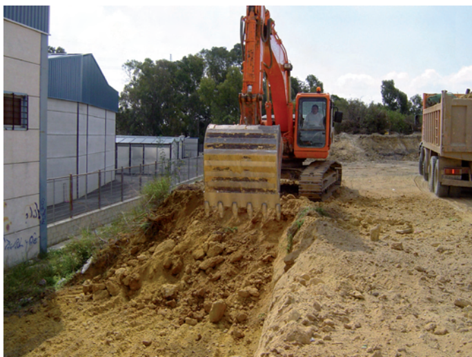
Lámina I. Maquinaria realizando el desmonte I, pk 110 + 600. Inicio Trazas.
