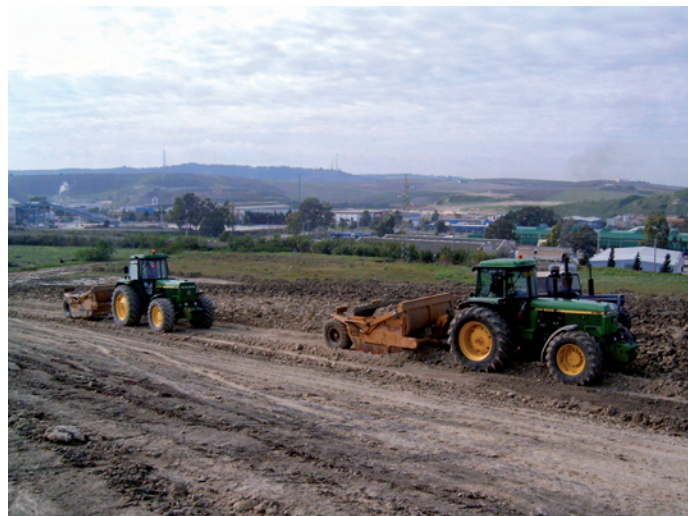
Lámina II. Traillas desmontando en pk 1,800.
