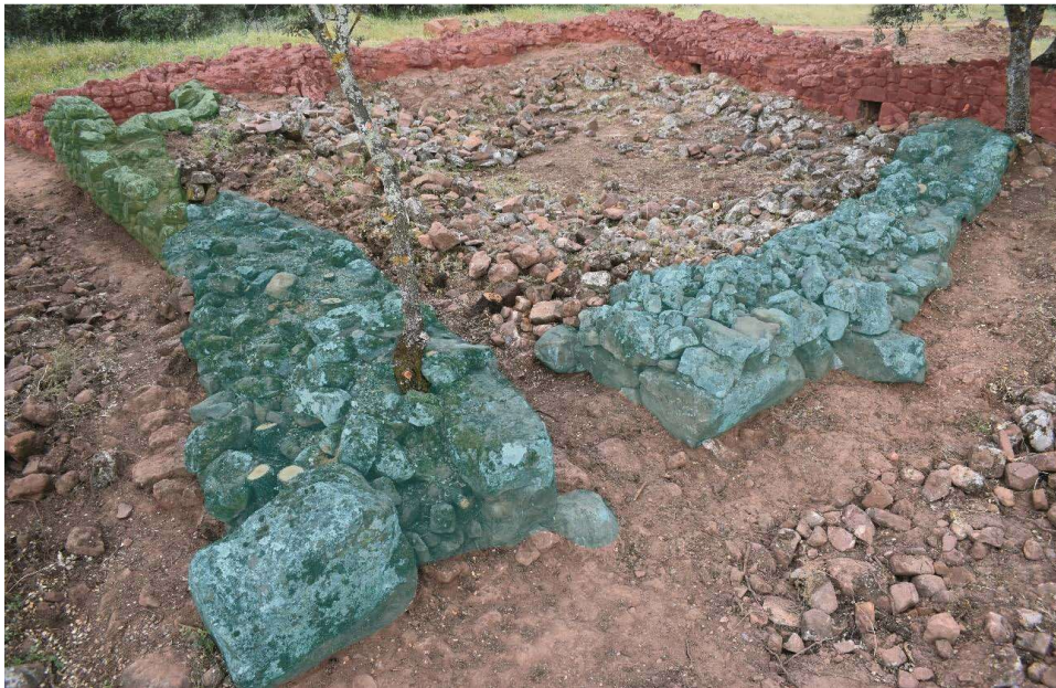
Fig. 2. Fases constructivas de Las Mirabelas.
