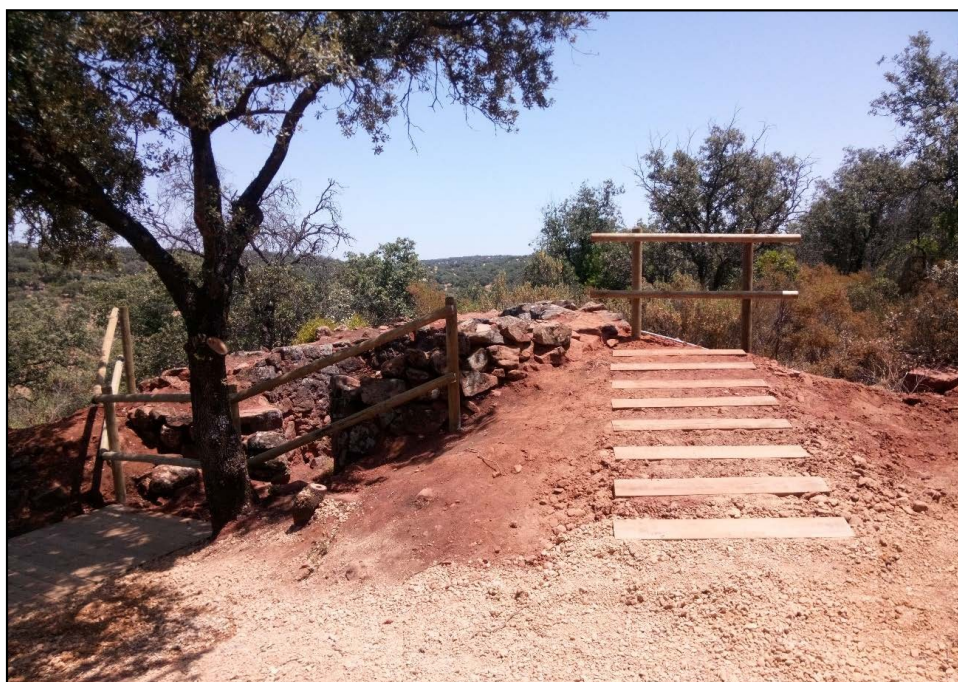
Lám. 1. Intervención en la Calera del Barranco del Tío Luis
