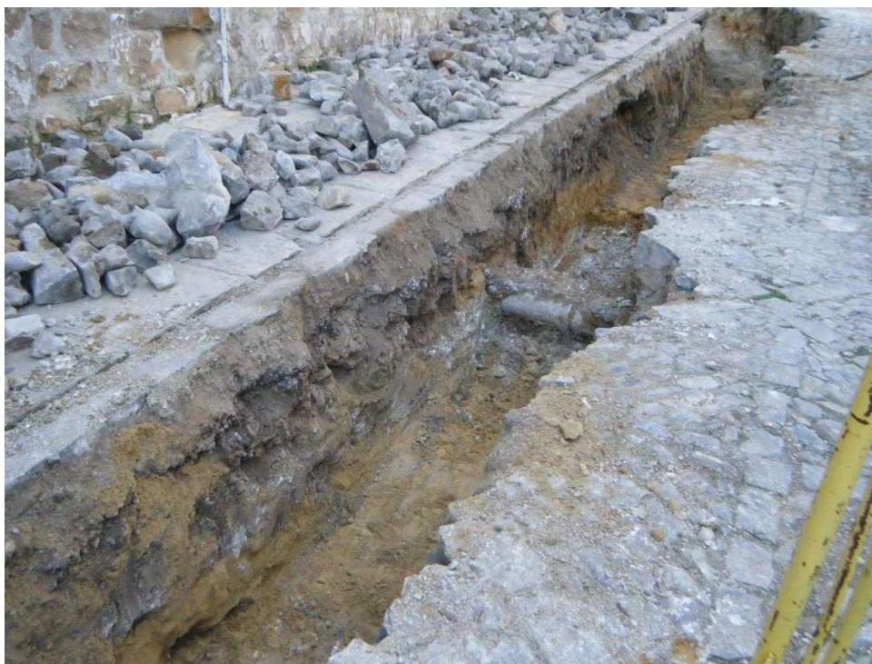
Fig., 2. Zanja en Tramo 1. Vista de la estratigrafía.
