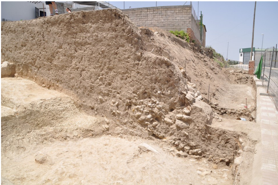
Figura 6. Sondeo Perfil Este y área de fachada delantera.
