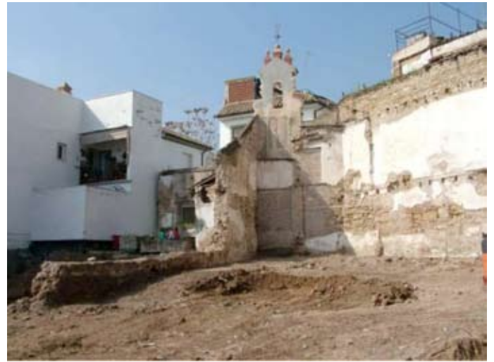
Lámina XII. Vista trasera de la espadaña de la ermita del Hospital de la Lámpara
