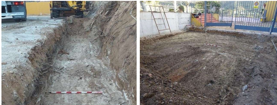
fig. 1. Apertura de la zanja de cimentación fig. 2. Rebaje de la zona del patio.
