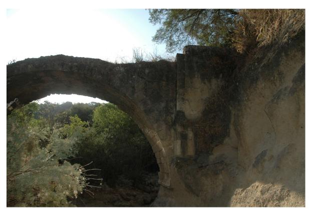
Como se señaló al comienzo, se trata de una estructura configurada por un arco de medio punto de 7 m de diámetro y 2.7 m de anchura, construido con sillares de piedra caliza local.
