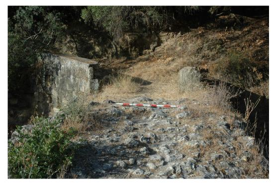
Los elementos mejor conservados son los estribos. El situado más cerca del molino es una estructura construida completamente, mientras el opuesto se encaja en el cañón rocoso del arroyo.
