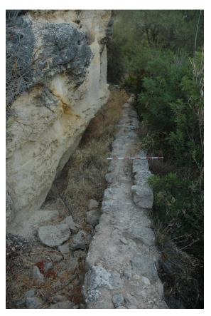
El edificio del molino posee, de manera genérica, dos pisos diferenciados. En la planta inferior, la cárcava, donde desemboca el canal por un imbornal llamado cauz.
