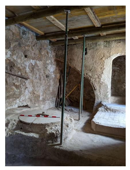
Por regla general, los mampuestos más grandes se colocan en esquinas y partes bajas, siendo en el resto de los muros de tamaños diversos. Sin embargo, en las puertas y en algunas reformas se empleó ladrillo. Por su parte, en la zona de las cárcavas se emplean sillares.
