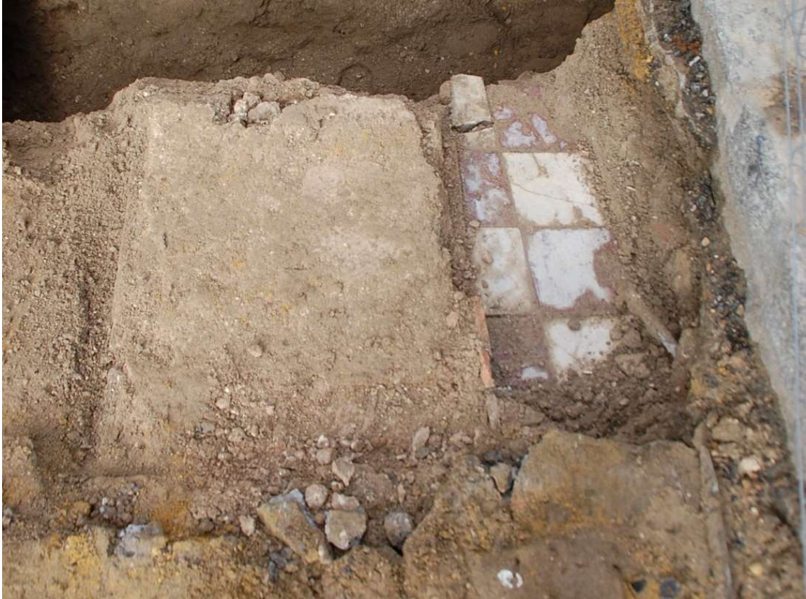
Lám. 9: Pavimento de losa hidráulica colocado en damero al interior de una de las casas previas al ensanche e identificado como unidad 4.
