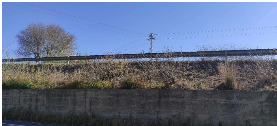
Fig. 5. Detalle la carretera por la que cruzará la línea de evacuación
