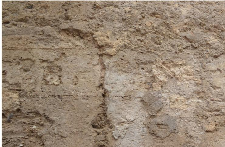
**Figura 7.** Detalle de la banda longitudinal y huellas de la tabla del cajón en la superficie calicestrada de la tapia.
