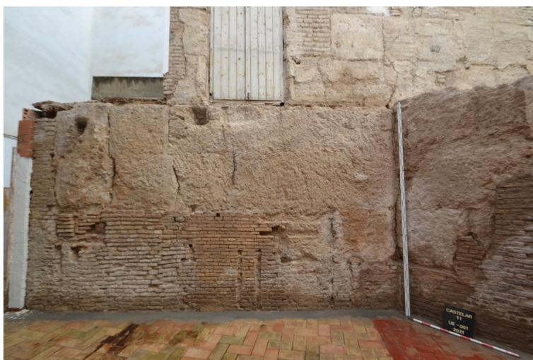
**Figura 10.** Pérdida de masa de la muralla. Adviértanse las refacciones con ladrillo de la parte inferior y las grietas en la tercera bancada.
