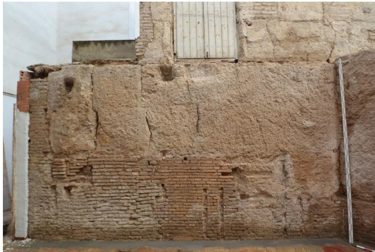
**Figura 2.** Mitad meridional de la muralla. Aparece desbastada en todo su espesor hasta la vertical del parapeto.
