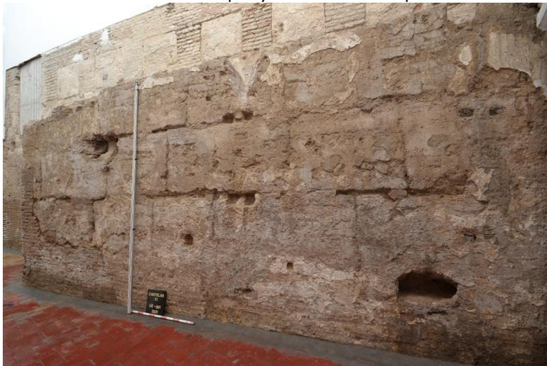
**Figura 4.** Alzado de la muralla en su mitad norte. Se aprecian las cuatro bancadas de tapial, el adarve y el almenado.
