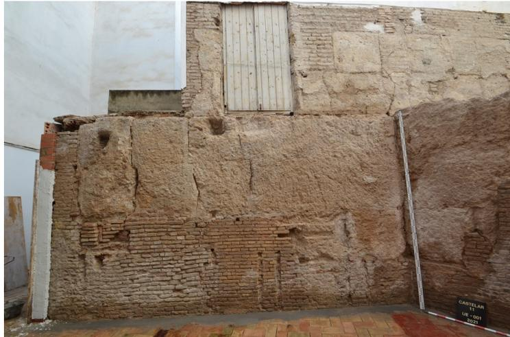
**Figura 9.** Puerta (ue 14) que comunicaba las dependencias de Castelar 11 y Valdés Leal 21, previamente al desbastado actualmente visible en la muralla. Obsérvese la ruptura del almenado y parapeto practicada para introducir la puerta.
