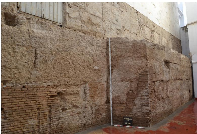
**Figura 3.** Corte de la muralla de tapial y refuerzo de la esquina mediante ladrillos.
