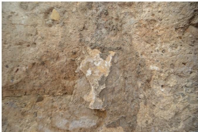
**Figura 14.** Detalle del revestimiento más antiguo documentado, aplicado directamente sobre el calicastro de la muralla.
