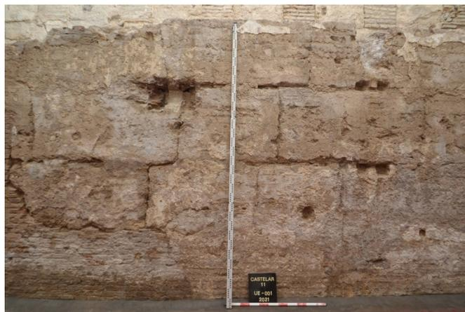
**Figura 13.** Imagen de detalle de los cajones de tapial sobre la fábrica latericia. La parte de la izquierda corresponde con toda claridad a la reparación de la muralla tras su fragmentación. Sin embargo, en la parte derecha se observan discontinuidades que podrían responder a momentos diferentes en la ejecución de este aparejo. Podría tratarse de una faja de ladrillos colocada en el momento de construcción de la muralla
