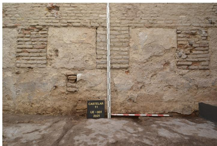
**Figura 6.** Detalle de los merlones del almenado.
