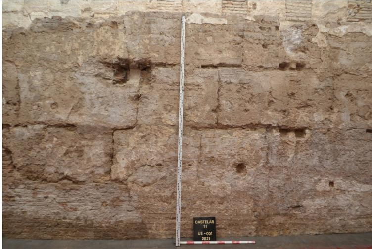
**Figura 8.** Huellas de empotramientos diversos sobre la muralla. A la derecha abrazaderas de un bajante metálico.
