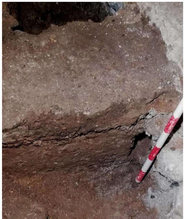
**Ilustración 8:** *Muro de tapial 7 cara N y cara S, ambas con impronta del encofrado*
