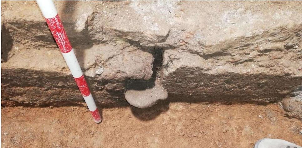
**Ilustración 9:** *Junta de 2 cajones de tapial en el Muro 8*
