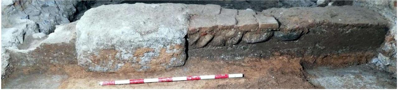
**Ilustración 2:** Este del Muro 2, cortado por zapata de calicanto; tranco de ladrillo y cantos.
