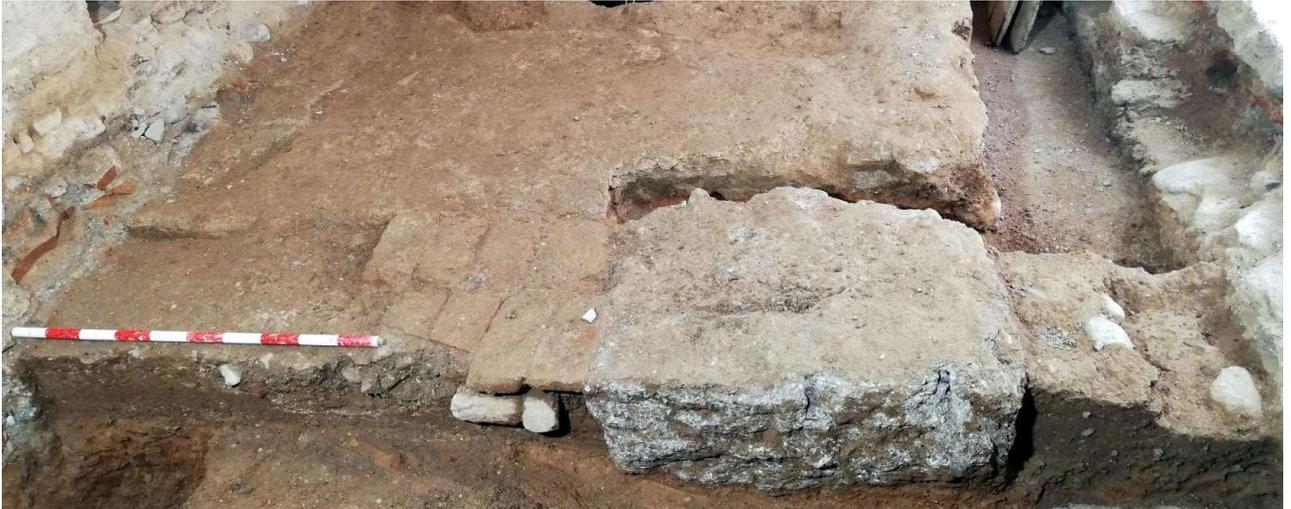
**Ilustración 3:** Lateral oeste del Muro 2; técnica de tapial y pavimento adosado al lateral este.
