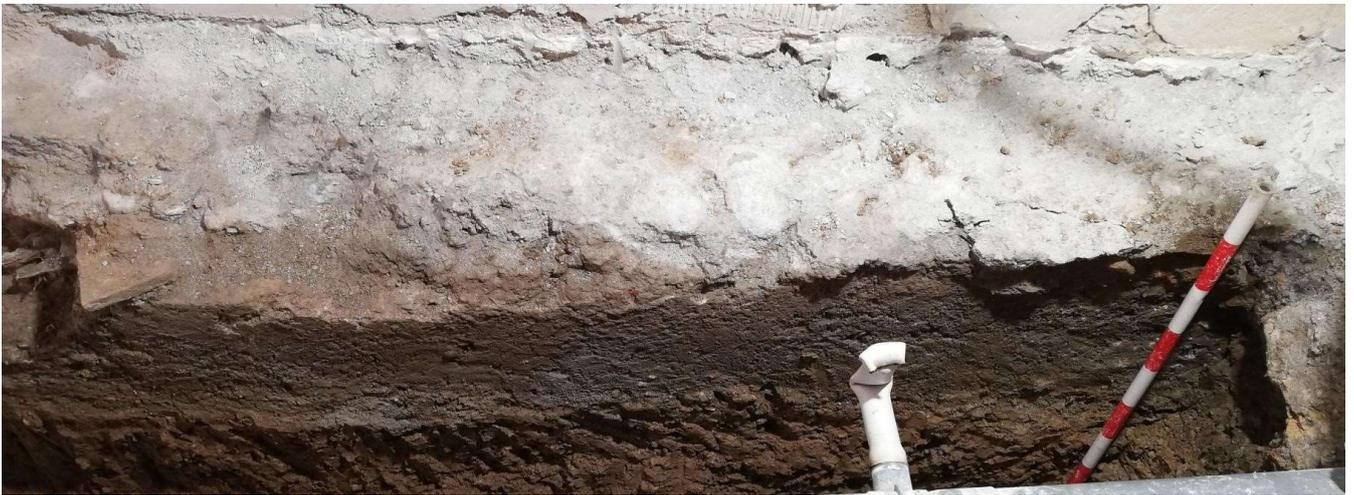
**Ilustración 6:** *Muro 4 de tapial, con cimentación del edificio actual encima.*
