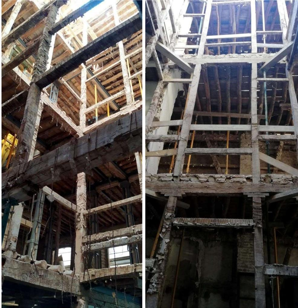
**Ilustración 18:** *Armazón de madera del edificio.*
