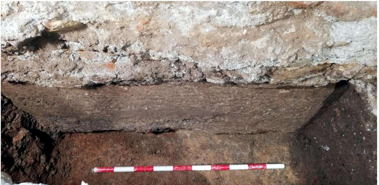
**Ilustración 7:** Muro de tapial 1, en la esquina NE, bajo la cimentación actual perimetral N.
