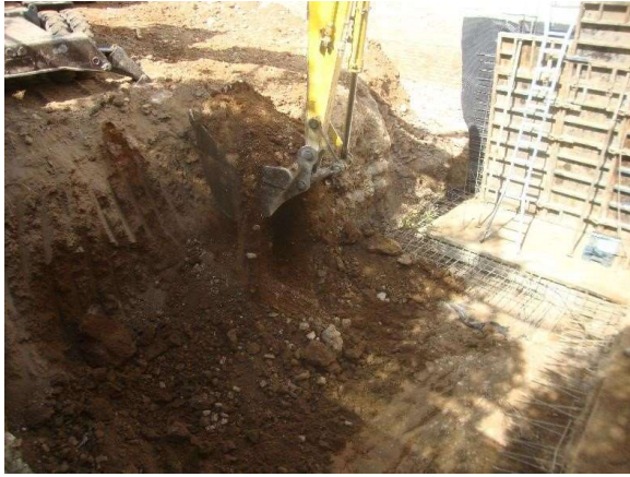
Lám.14. Últimos movimientos de tierras.
