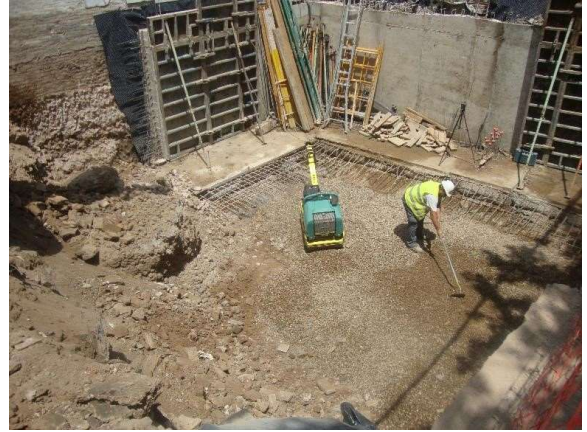
Lám. 15. Se observa el vaciado mediante esta técnica.
