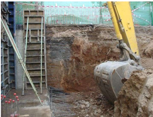
Lám.12. Maquinaria labores de rebaje.
