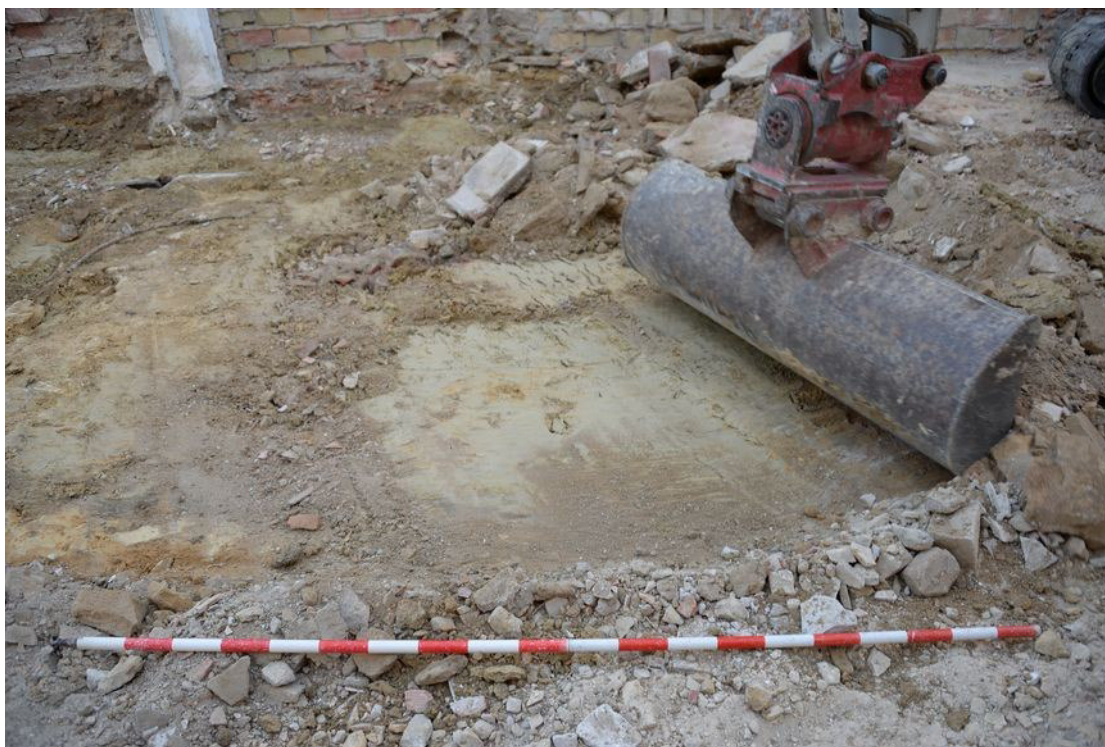
Fig. 7. Detalle del raspado superficial, apareciendo las gredas geológicas inmediatas. Fuente: Fototeca de ARQVIPO. Sign. FD-2021-06-03-ND610-047.
