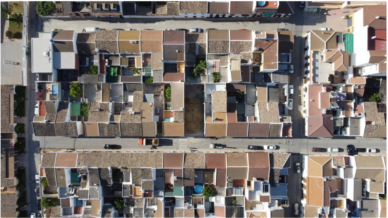
Fig. 1. Vista aérea de la manzana con el solar durante el proceso del Control Arqueológico. Fuente: Fototeca de ARQVIPO. Sign. FA-2021-06-03-DJIM2-008.
