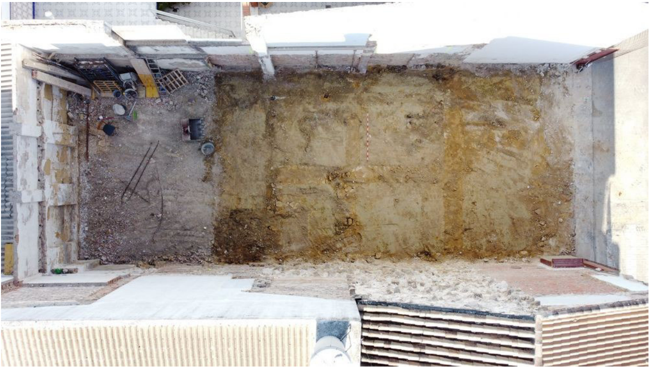
Fig. 3. Vista del solar tras la retirada del nivel superficial de suelos contemporáneos, apareciendo los niveles de gredas geológicas y las cimentaciones y espacios de la vivienda demolida. Fuente: Fototeca de ARQVIPO. Sign. FA-2021-06-03-DJIM2-043.
