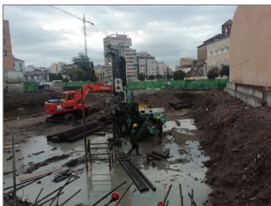
Trabajos de pilotaje en el sector central del solar.
