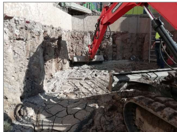
Micropilotes y retirada de lodos en el sector calle Agustín Parejo.
