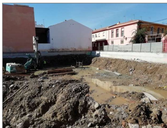
Trabajos de pilotaje en el sector central del solar.
