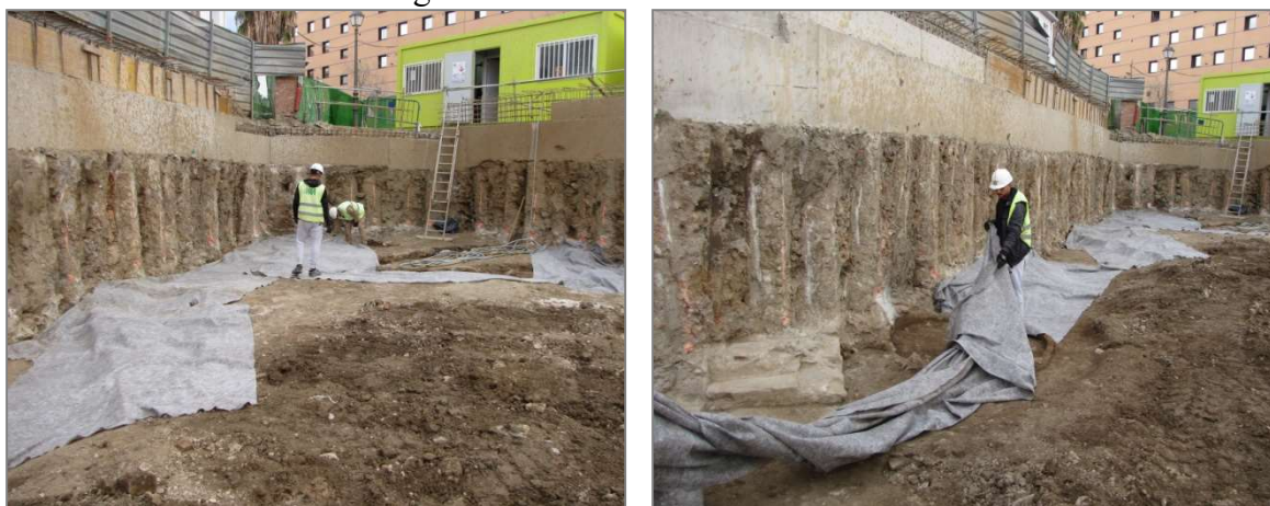
Cubrición de las estructuras documentadas en el sector de calle Agustín Parejo.
