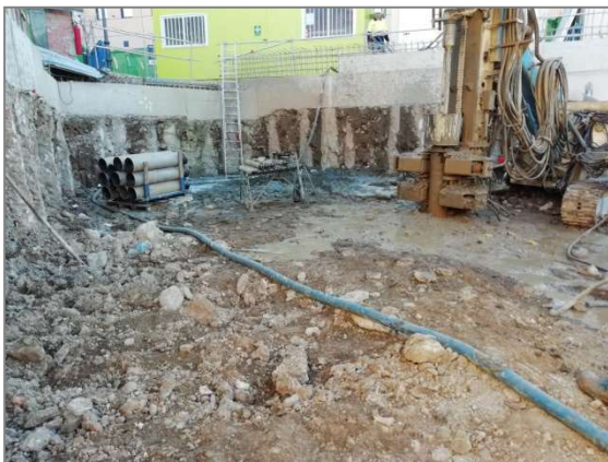
Micropilotes y retirada de lodos en el sector calle Agustín Parejo.
