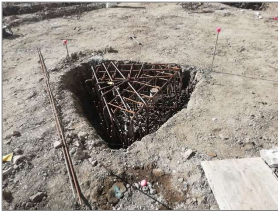
Preparación de encepados y vigas arriostrantes.
