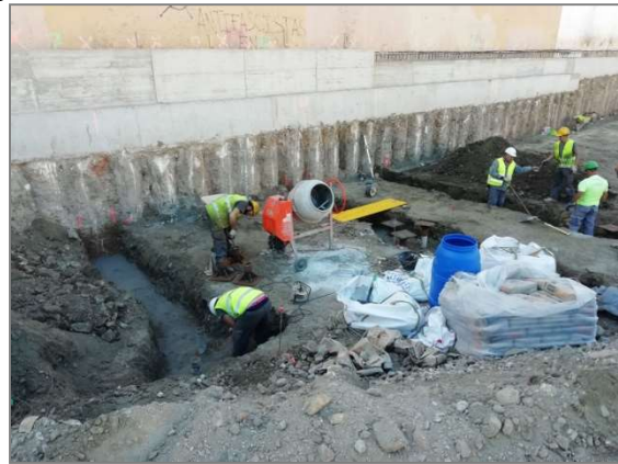
Preparación de encepados y vigas arriostrantes.
