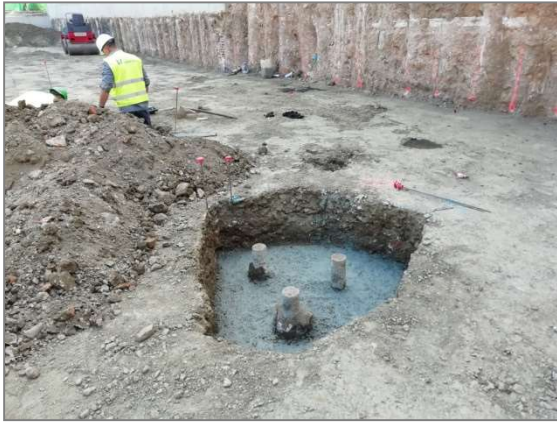
Trabajos de compactación a cota de rasanteo y excavaciones de encepados y vigas, sobre terreno aportado.
