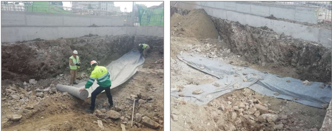
Cubrición de estructuras.
