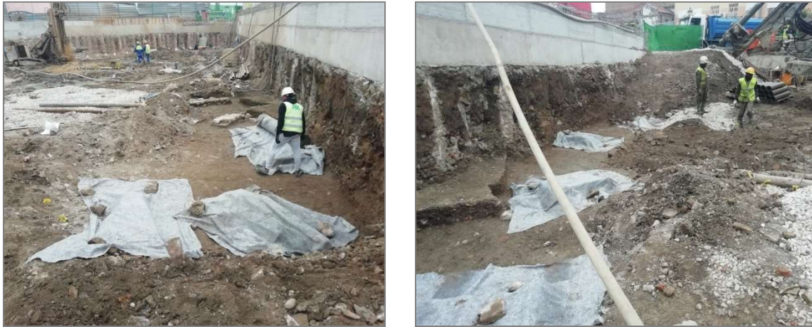
Cubrición de las estructuras del sector calle Padre Jorge Lamothe
