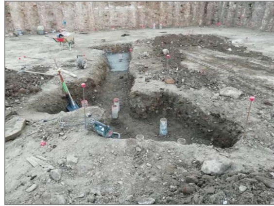
Trabajos de compactación a cota de rasanteo y excavaciones de encepados y vigas, sobre terreno aportado.
