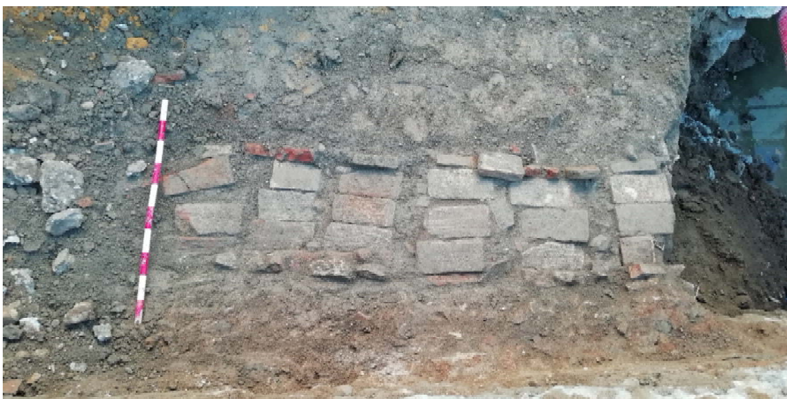
Lam. 7. Cubierta de la cloaca almohade UE 23 realizada con ladrillo de plano.
