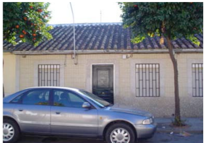
Lámina I. Vivienda demolida en calle Don Quijote, nº 86
