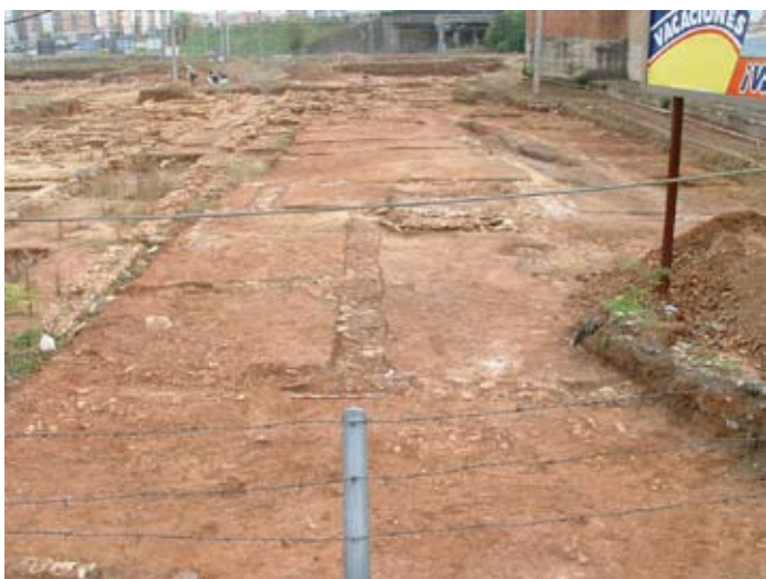
Lámina III. Documentación de la red de muros que forman los espacios domésticos.
