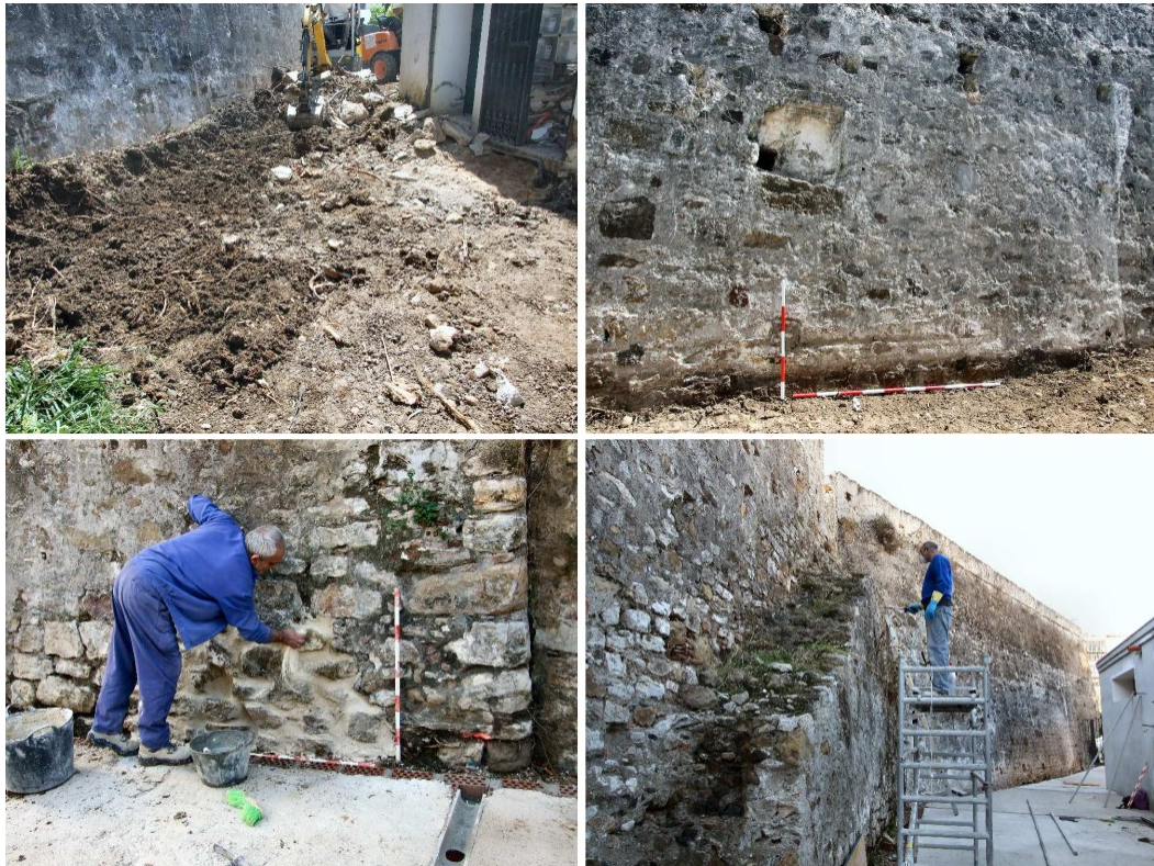
Figura 3. Trabajos de restauración en el castillo de San Luis
