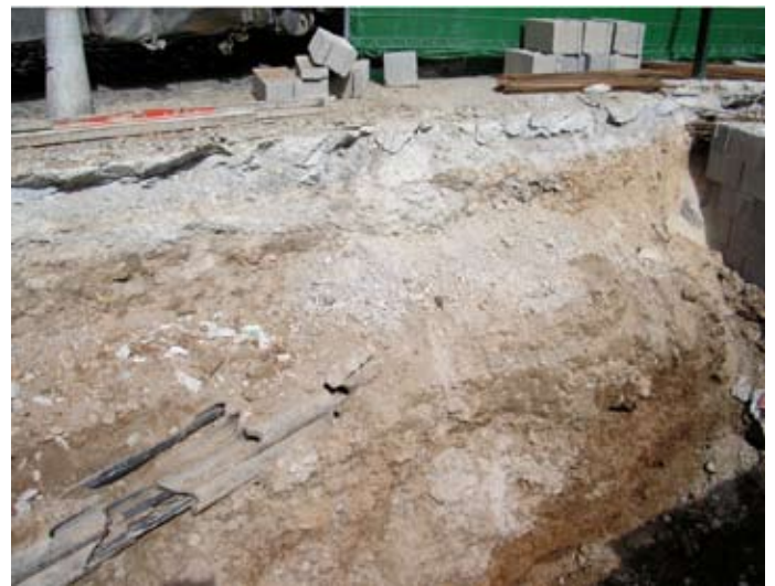
Lámina II. Sondeo 2. Vista general.
