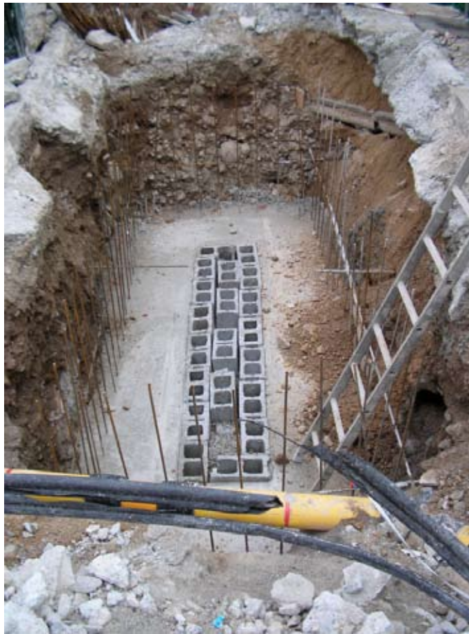
Lámina III. Sondeo 1. Vista general al final de la intervención.
