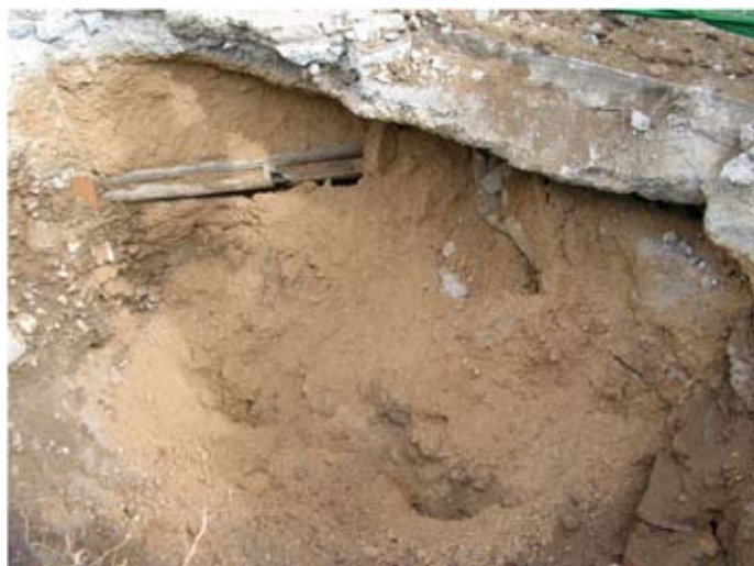
Lámina II. Sondeo 1. Detalle del perfil Norte.
