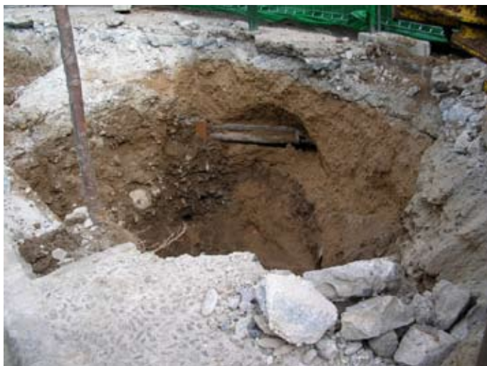
Lámina I. Sondeo 1. Detalle de la E-004.
