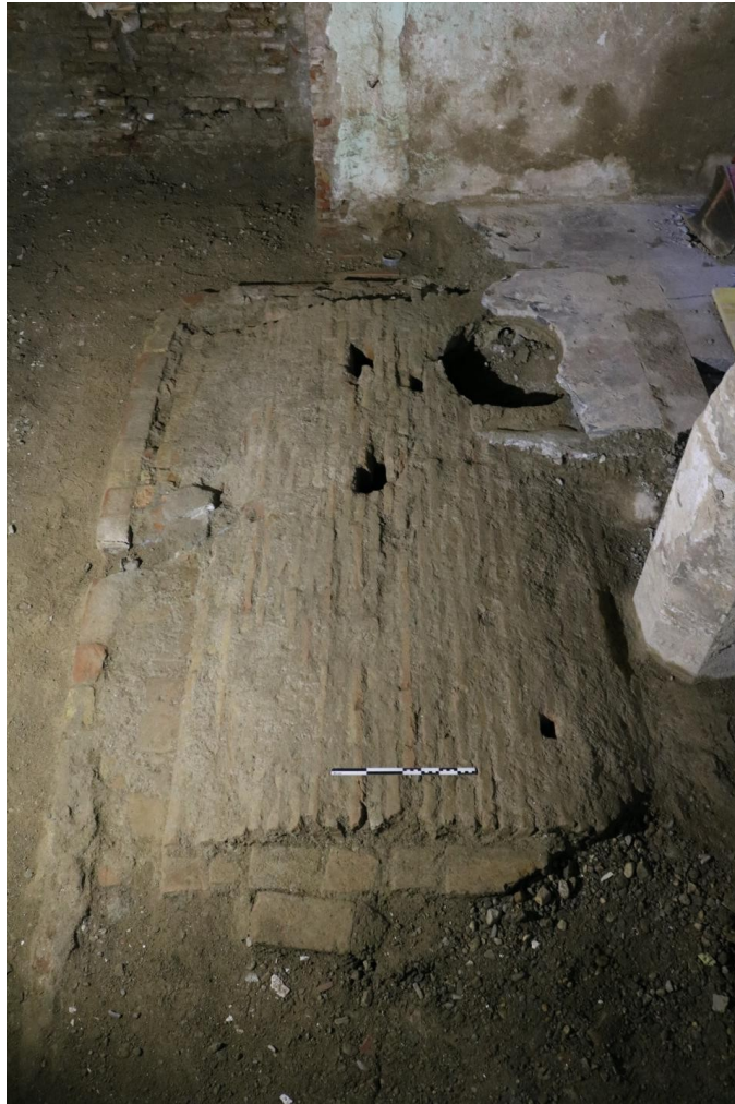
Lámina VI. Cisterna moderna en ladrillo en el Local 3 con fachada a San Jerónimo.
