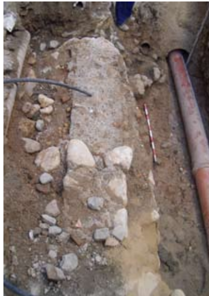
Perspectiva de la excavación y vista desde arriba del primer tramo descubierto.
