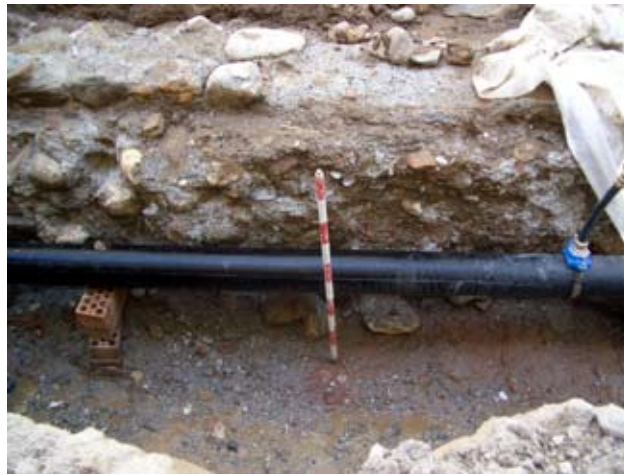
Vista frontal de la estructura completa. Adaptación del paso de la tubería de abastecimiento.
