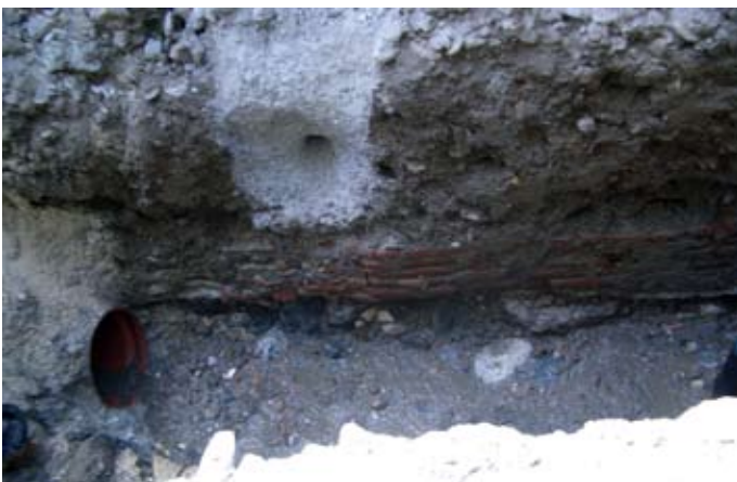
Pared de ladrillo de la conducción de agua
