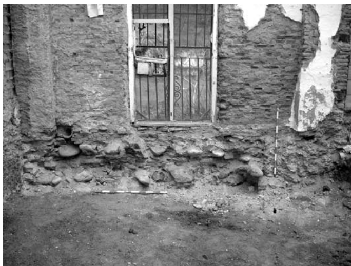
Lámina I. Perfil 1, situado en la fachada que da al río Darro, donde se combinan hiladas de ladrillos y piedras.
