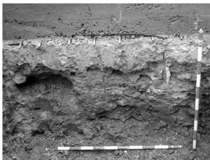
Lámina VI. Perfil 6, uno de los perfiles del foso del ascensor.
