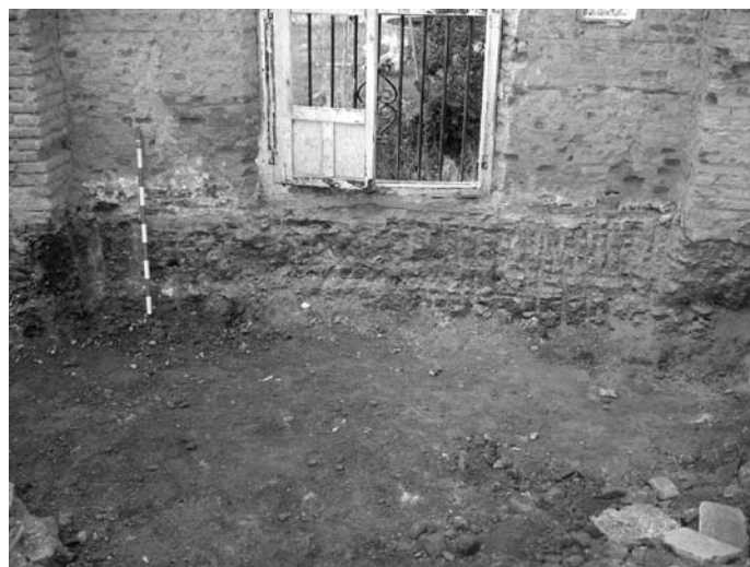
Lámina II. Perfil 2, situado en la fachada que da al río Darro, donde sólo aparecen hiladas de ladrillos.
