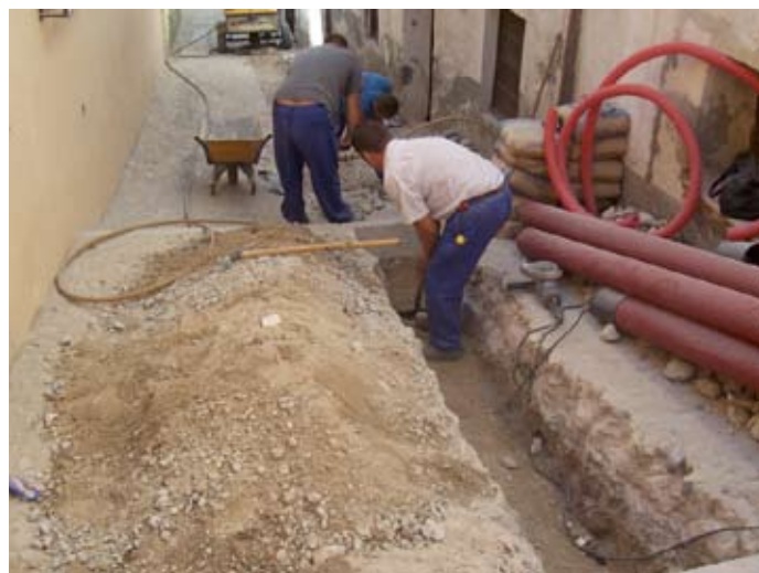
Lámina II. C/ Gumiel. Tramo 2. Apertura manual de la zanja.
