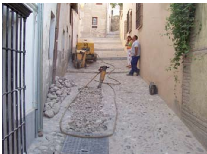
Lámina I. C/ Gumiel. Tramo 1. Levantamiento empedrado.
