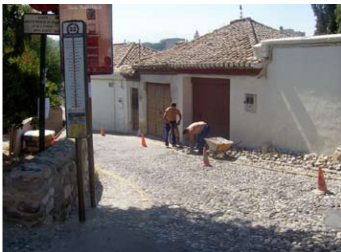
Lámina IV. Callejón de las Tomasas. Levantamiento empedrado
