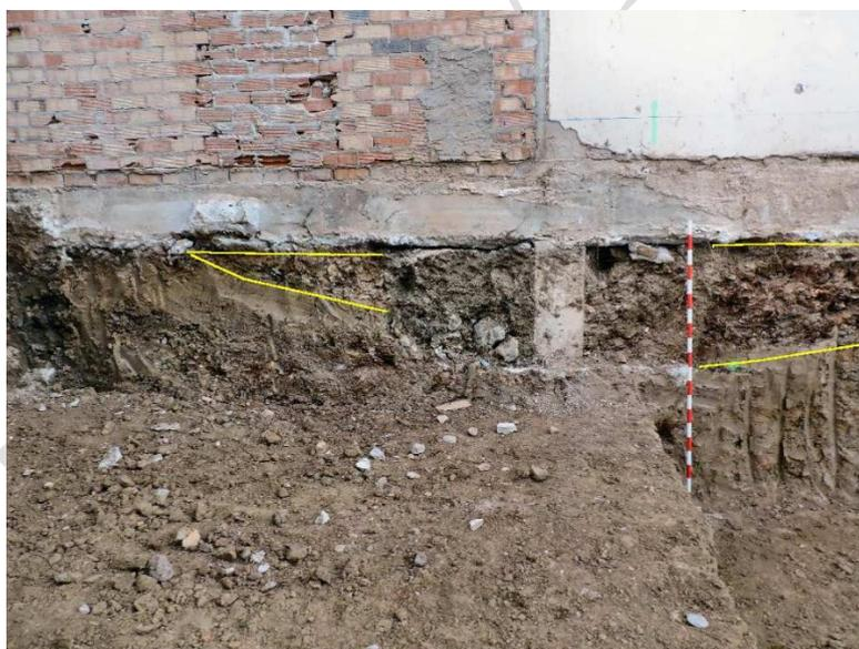
Figura 4. Detalle de ue-2 intersectada por la cimentación del edificio vecino por el noreste
