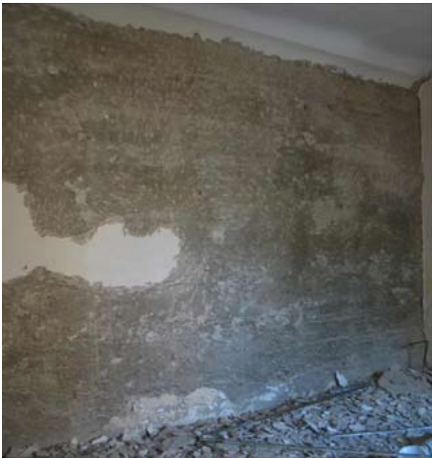
Figura 1. Habitación 2: se observan las marcas de la retirada de la capa de yeso.
