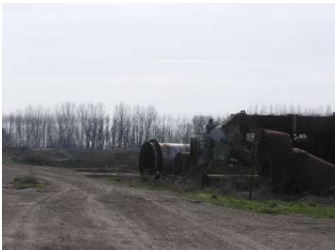
Lámina VII. El itinerario del Gasoducto termina en las proximidades de la Estación del ferrocarril
