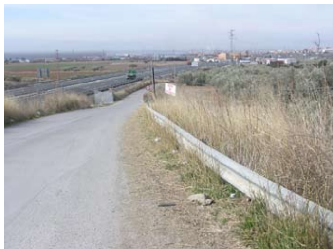
Lámina II. Camino de servicio de la Autovía A- 92 por donde discurre gran parte del trazado del Gasoducto.
