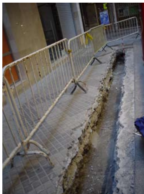
Lámina III. Vista general de la zanja una vez abierta.
