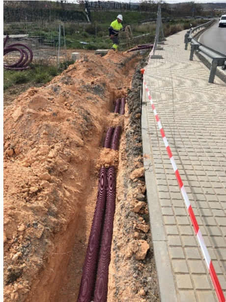
Fig. 5 Zanja alumbrado
