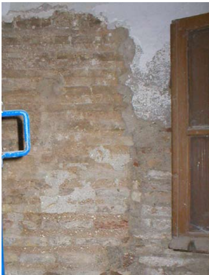
Lámina II. Anclaje de la antigua puerta.
