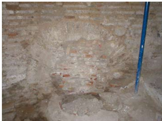
Lámina I. Pozo y vano cegado en muro perimetral W.
