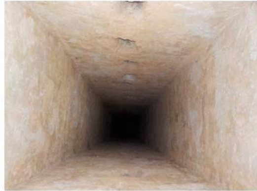
Imagen del interior con los mechinales.
