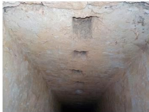
Detalle de los mechinales.
