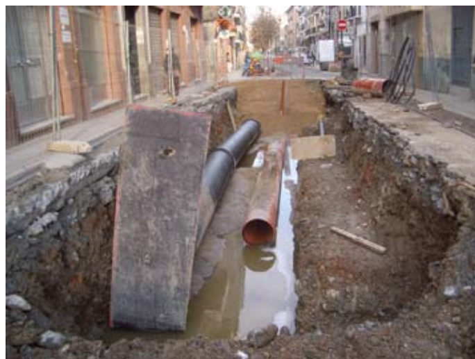
Lámina II. Perspectiva de la obra al comienzo del tramo II.
