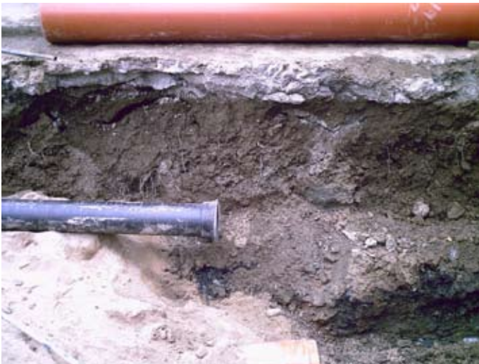
Lámina VII. Instalación nueva tubería.
