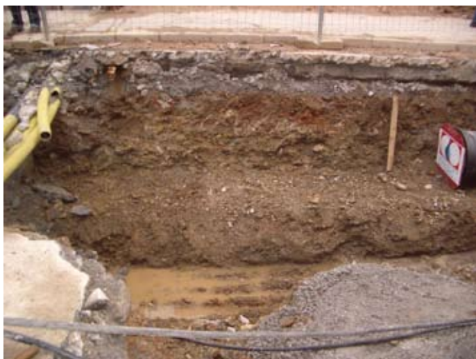
Lámina I. Perfil de la excavación.
