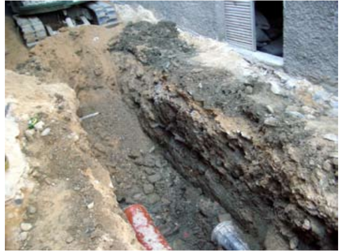
Lámina VI. Perfil de la zanja.
