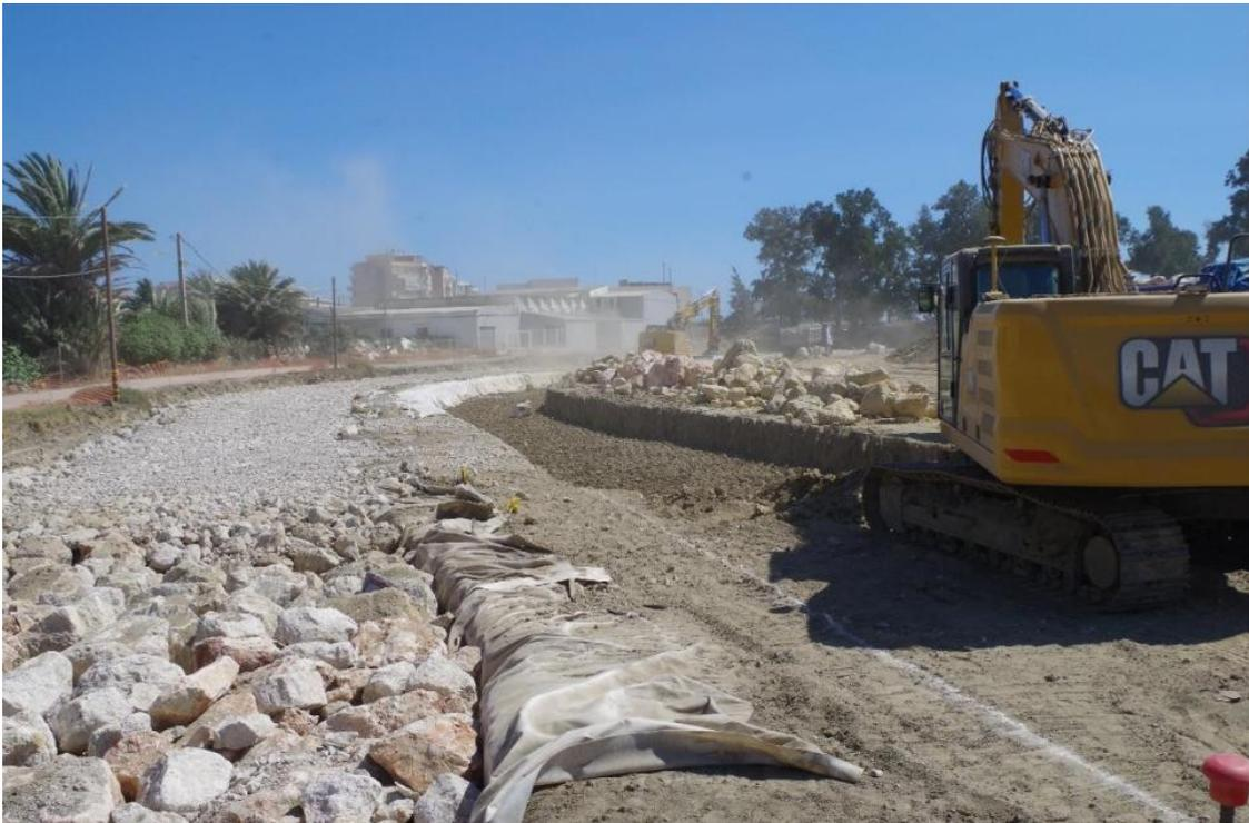
Fig. 2. Detalle de la apertura de la zanja y del relleno de escollera.
