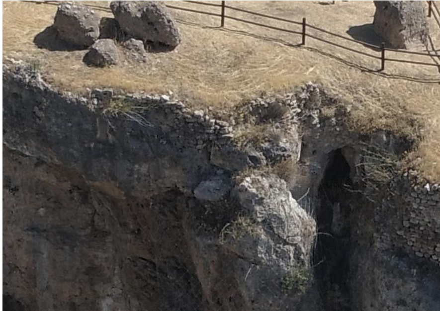
Lámina 26. Vista aérea del Tramo 6
