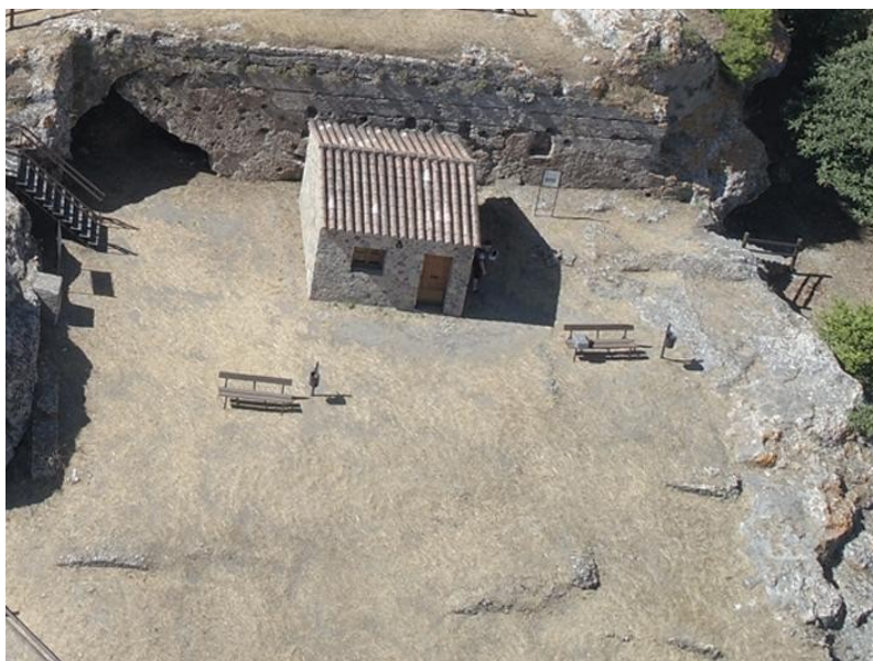
Lámina 37. Vista aérea de las estructuras del Tramo 8 en la Terraza Inferior
