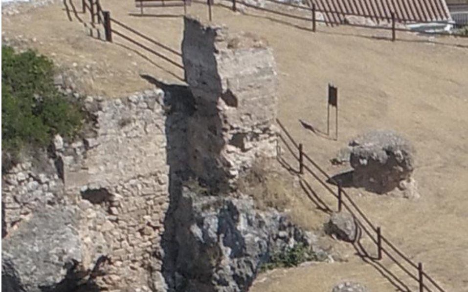
Lámina 28. Vista aérea del Tramo 7
