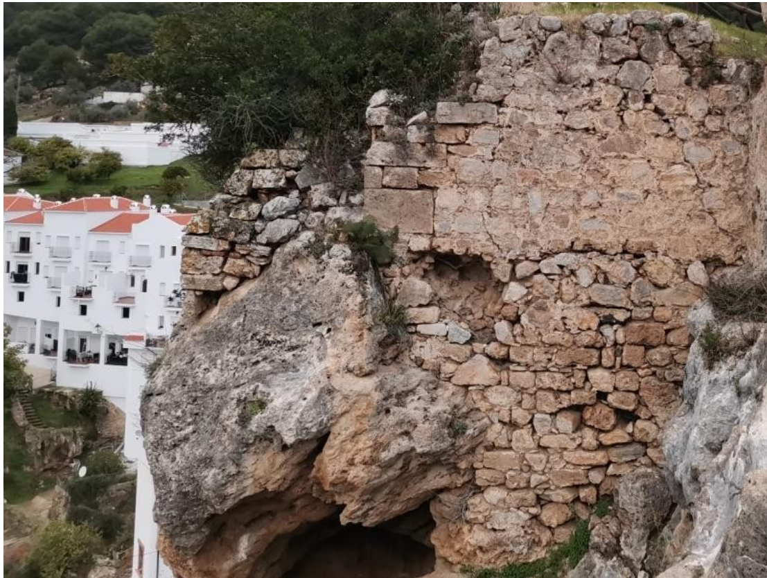
Lámina 31. Fábricas de mampostería y de sillería de la Torre 4
