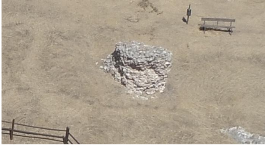
Lámina 33. Vista aérea de la Torre 5
