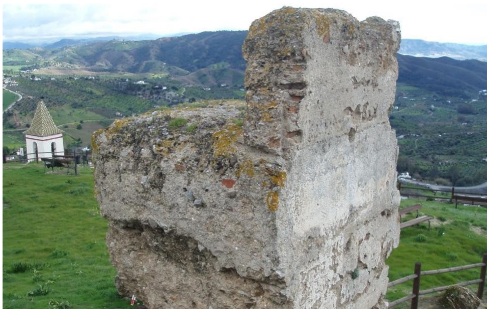
Lámina 29. Fábrica de tapial de calicanto del Tramo 7
