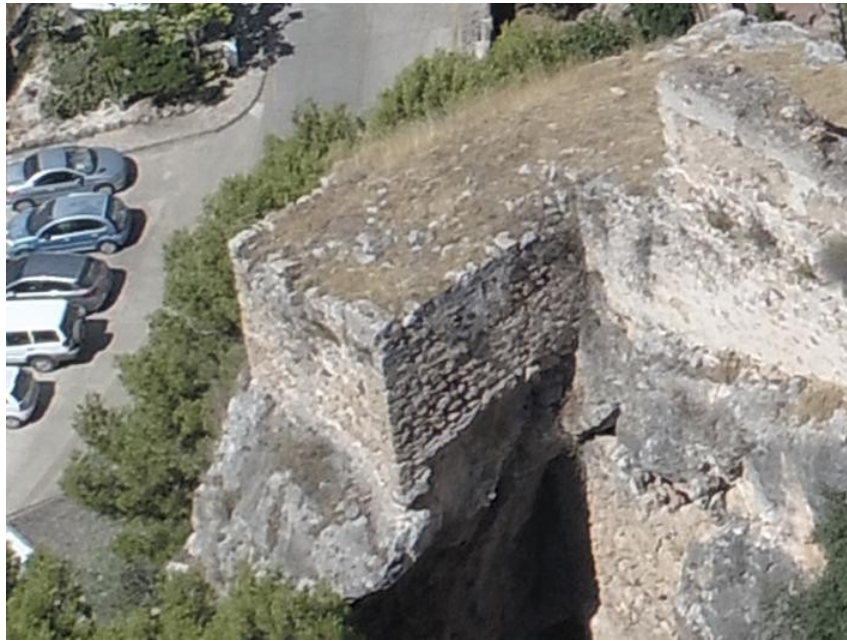
Lámina 20. Vista aérea de la Torre 3
