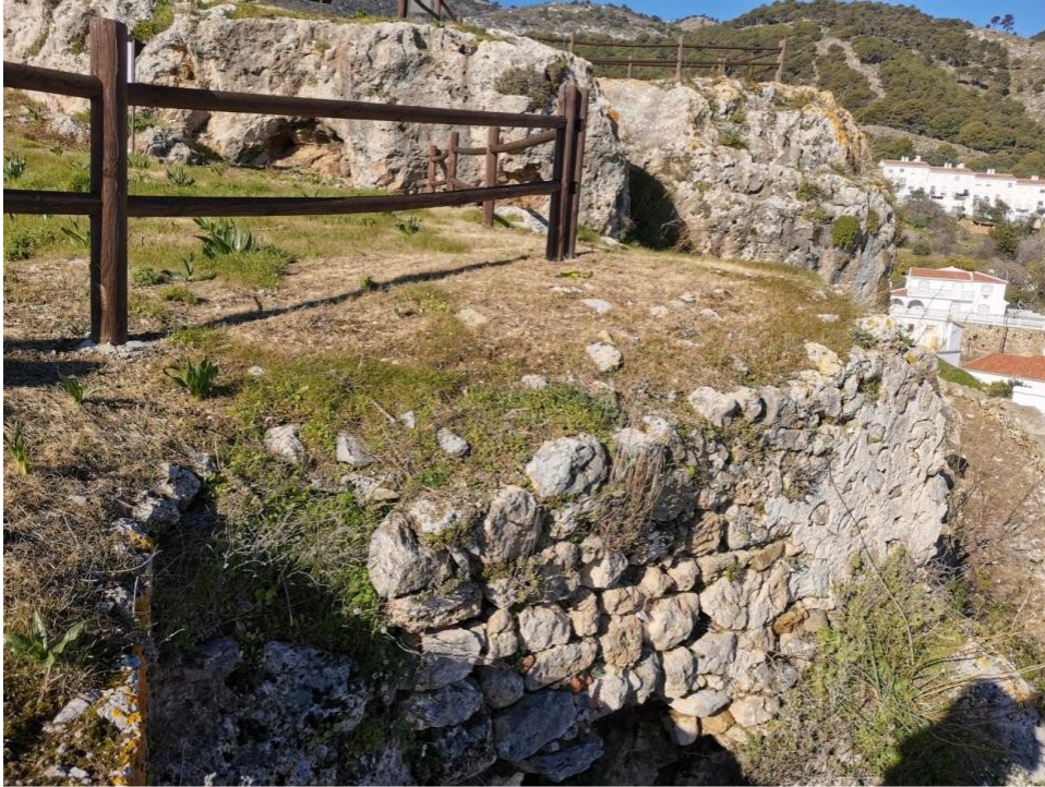
Lámina 14. Lienzo de muralla del Tramo 2
