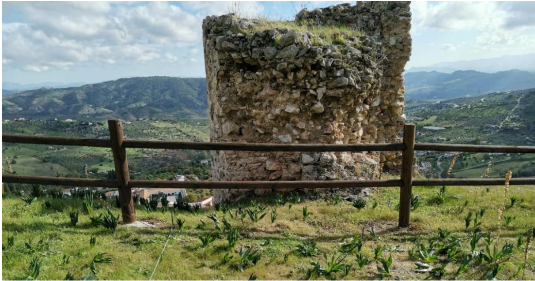
Lámina 16. Vista de la cara Oeste de la Torre 2
