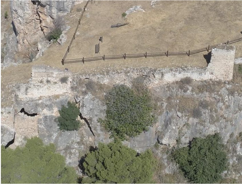
Lámina 18. Vista aérea del Tramo 3
