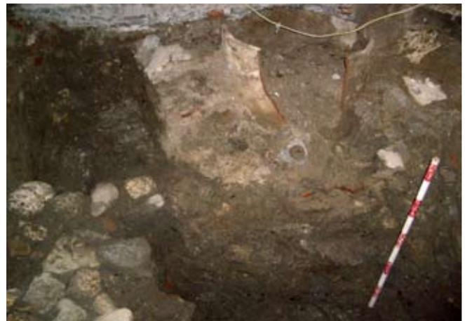
*Rotura del muro por el depósito de agua. A la derecha materiales sobre los que apoyaba el muro.*
