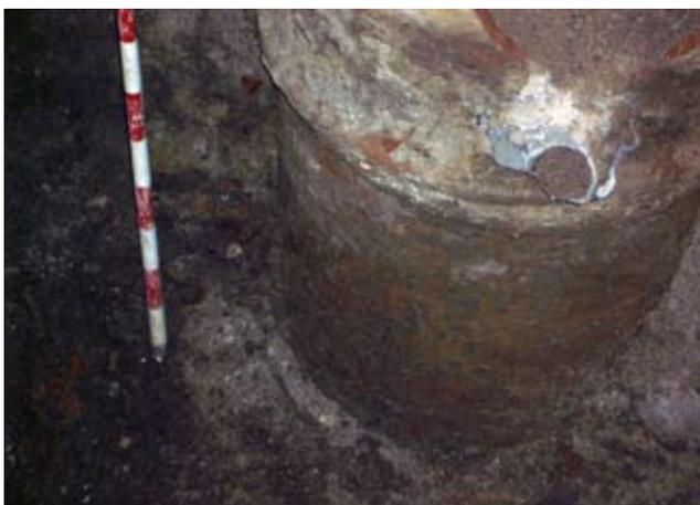
Finalmente se terminó la excavación y se preparó el sondeo para poder instalar el ascensor. Para ello fue necesario romper parte del depósito de agua. A la profundidad final de la excavación no se agotaron los niveles de relleno.
