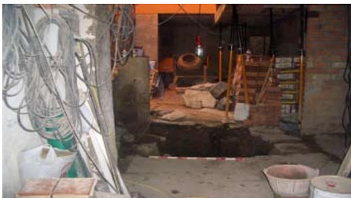
El comienzo de la excavación consistió en el levantamiento del suelo existente (losas calizas rectangulares) recibidas directamente sobre los rellenos inferiores, sin material de agarre.
