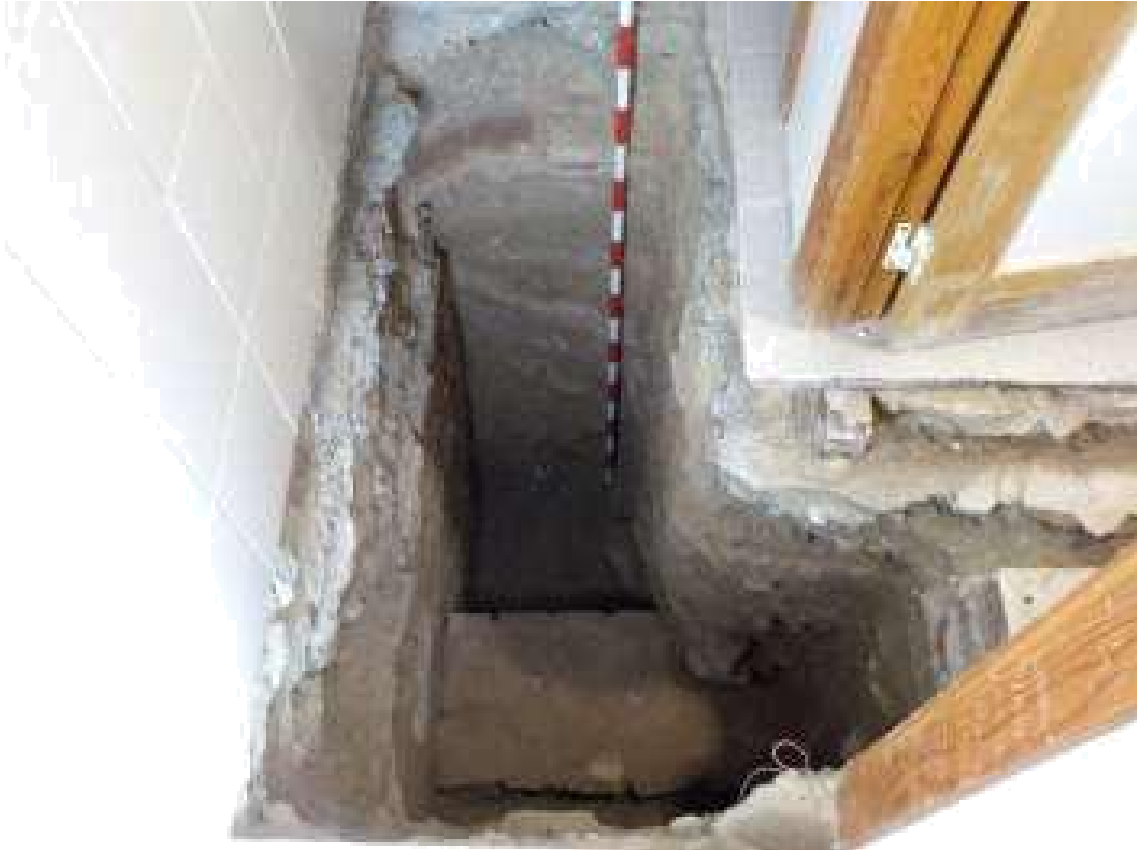
Lám. 5: Sondeo 1 en los aseos del Hospital Pascual.
