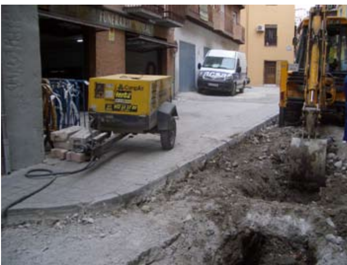
Perspectiva de la excavación. Se ve la tubería sustituida a poca profundidad.
