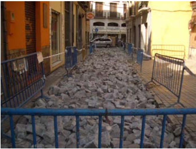
Perspectiva del primer tramo de calle afectado por la obra.
