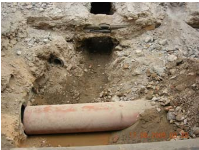
Excavación para acometidas. Se ve un paquete de color rojizo con pequeños fragmentos de ladrillos y gravas.
