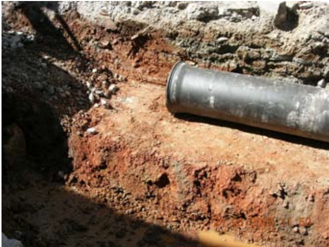
Excavación e instalación de las tuberías en el último tramo de la obra. Ver las tierras arcillosas limpias. En la página siguiente aparece un nivel rojo con muchas gravas sueltas. En esta zona bajo las tuberías se encontraban los conglomerados de la Formación Alhambra.
