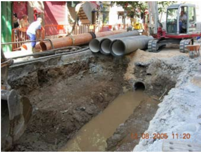
Excavación e instalación de las nuevas tuberías en el tramo intermedio.
