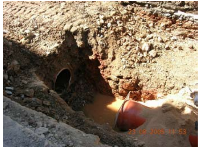
Excavación e instalación de las tuberías en el último tramo de la obra. Ver las tierras arcillosas limpias.
