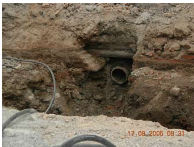
Excavación para acometida. Se ve el murete de ladrillo que envuelve una tubería, roto por la acometida sustituida.
