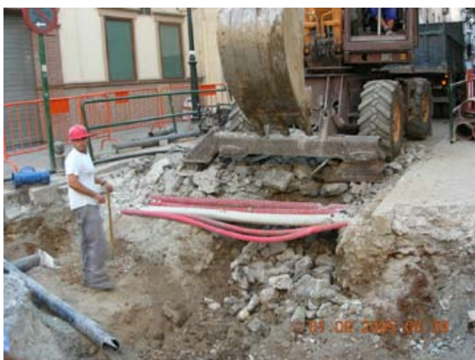
Comienzo de la excavación en la calle Molinos. Abajo se ve la tubería de saneamiento que se sustituyó.
