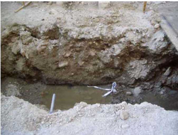
Perfil de la excavación. Se ve que todo son tierras de relleno.
