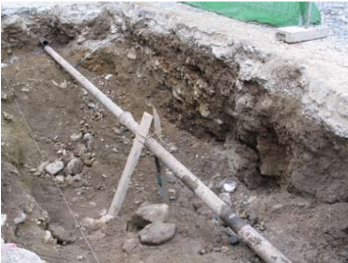
Lámina V. Excavación manual y tubería de agua en uso.
