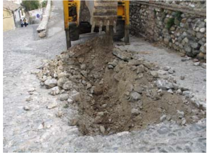
Lámina IV. Carril de la Lona. Inicio de excavación con medios mecánicos.
