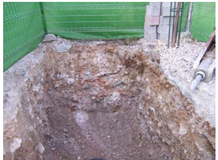
Lámina II. Vista general del sondeo en Placeta Carniceros.
