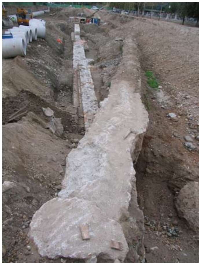
Vista general del muro de contención y colector.
