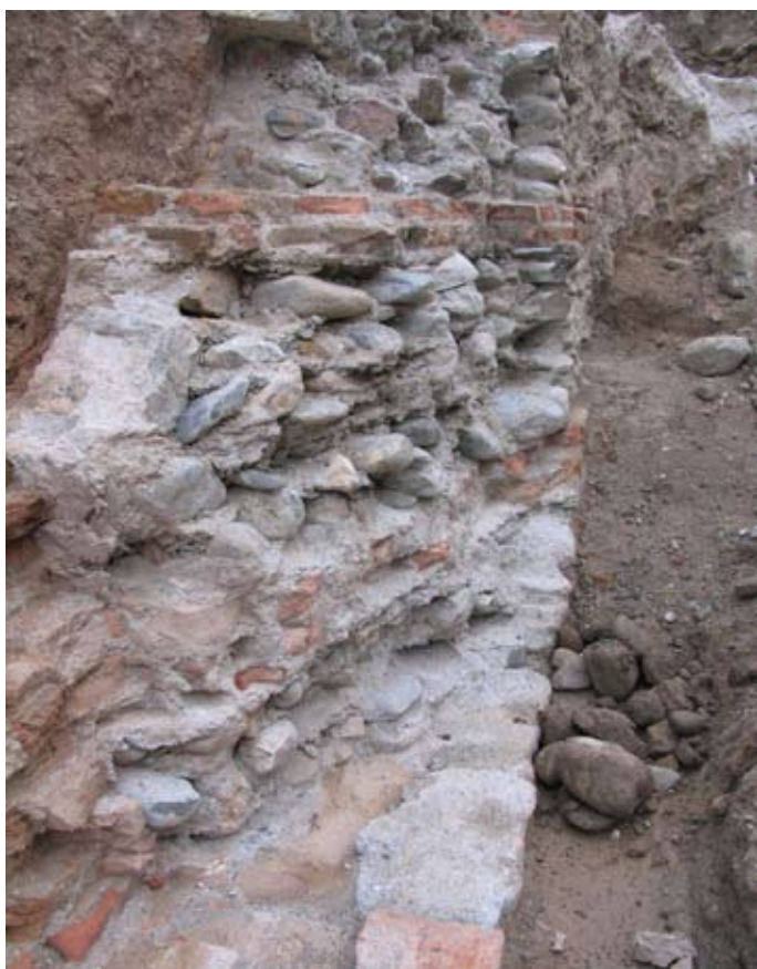
Detalle de la fábrica del muro contemporáneo.
