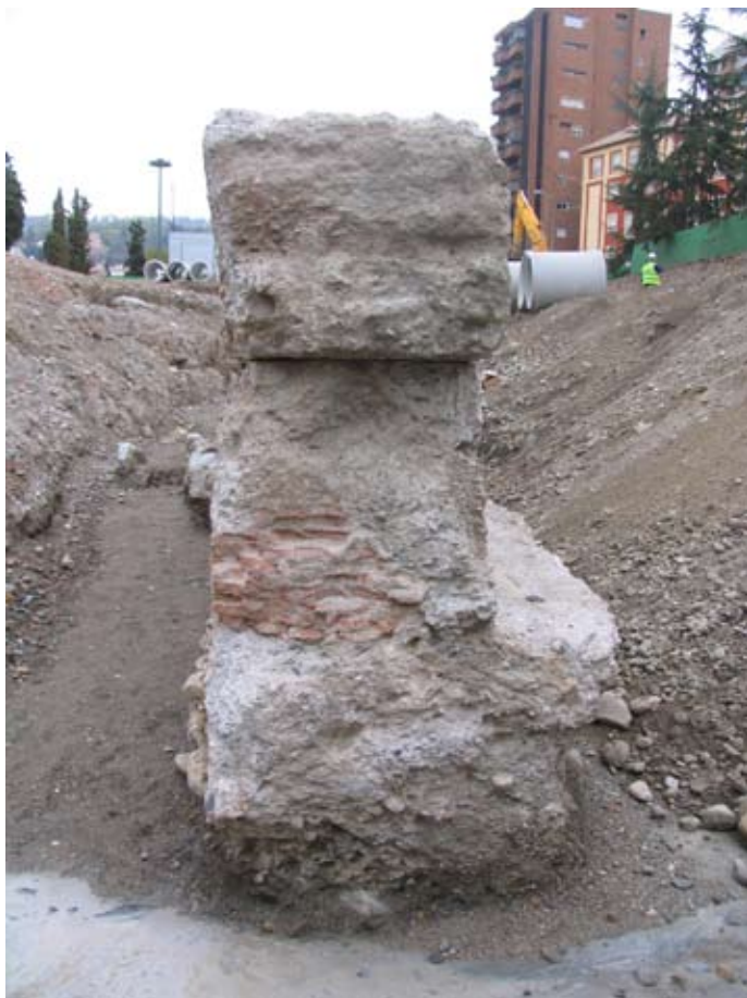
Sección general del Muro Islámico I.
