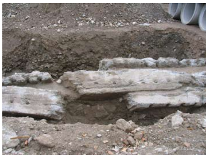
Vista general de Zona 2. Muro demolido.
