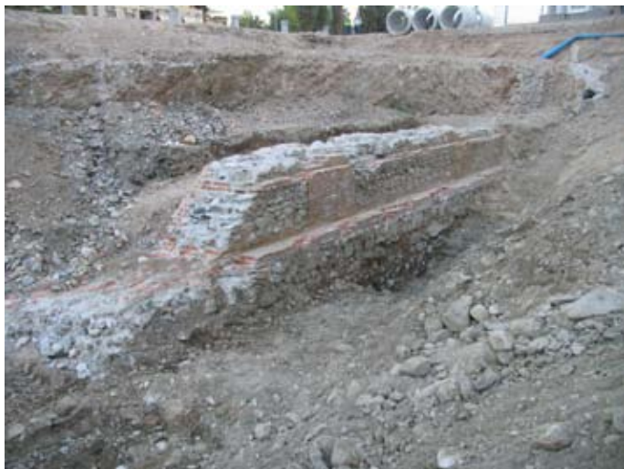
Vista general del muro contemporáneo. Cara interna.
