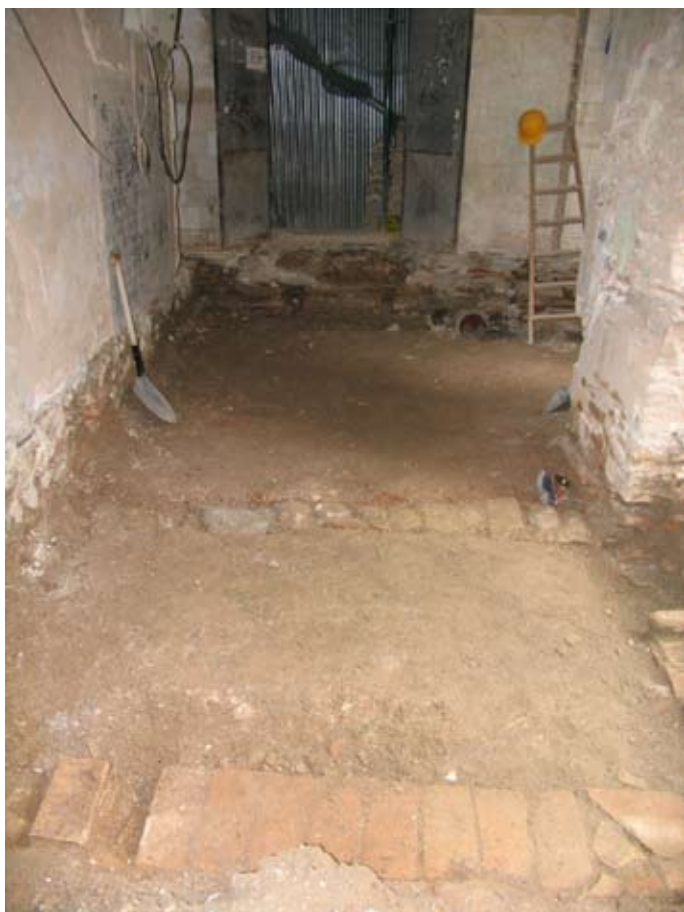
Lámina V. Detalle de la zona norte en su estado final.
