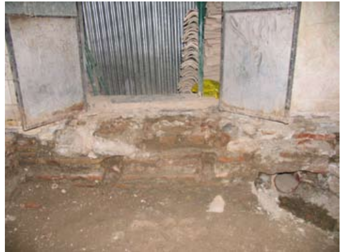
Lámina IV. Detalle de los goznes abiertos en el muro perimetral oeste.
