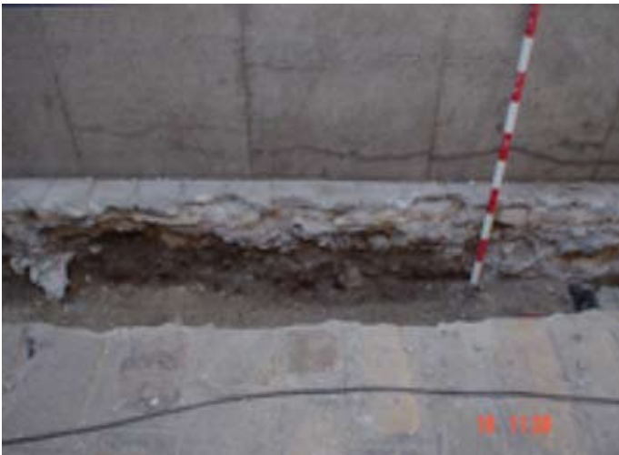
Lámina III. Vista de la zanja abierta en calle Pañera
