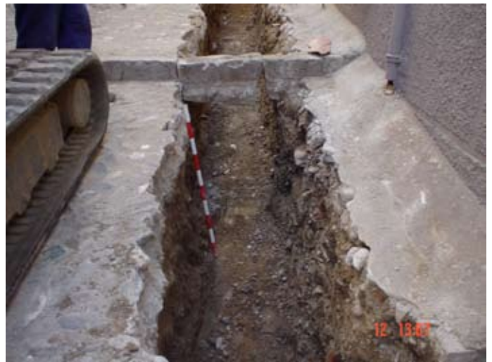
Lámina II. Vista de la zanja abierta en calle Monjas del Carmen
