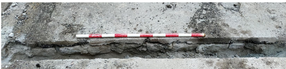
Ilustración 12: Adoquines de piedra natural del pavimento anterior.
