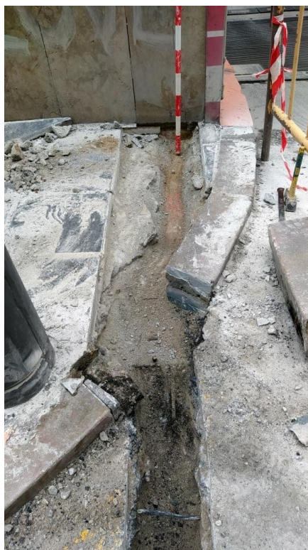
Ilustración 13: Imbornal y hormigón armado del sótano (parking).
