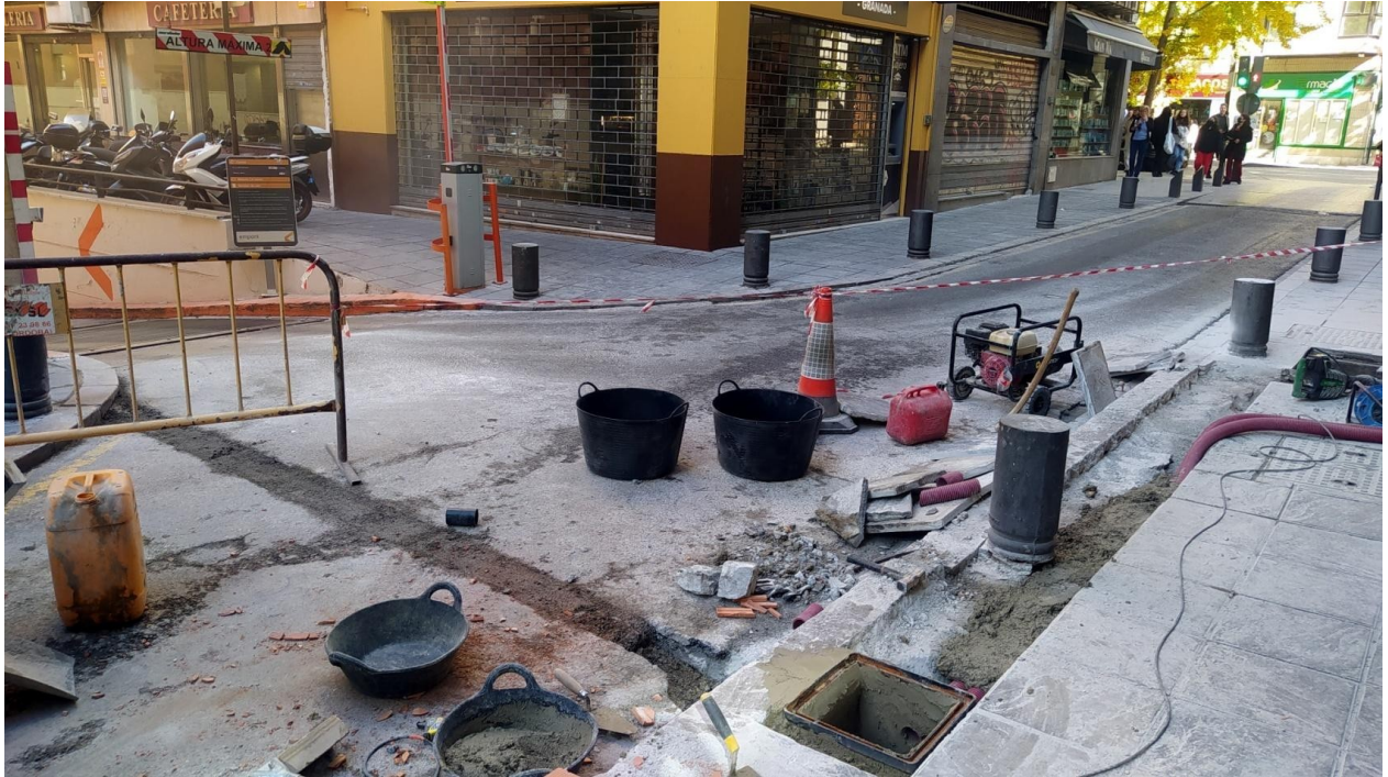
Ilustración 19: Las dos zanjas y la arqueta que las conecta.
