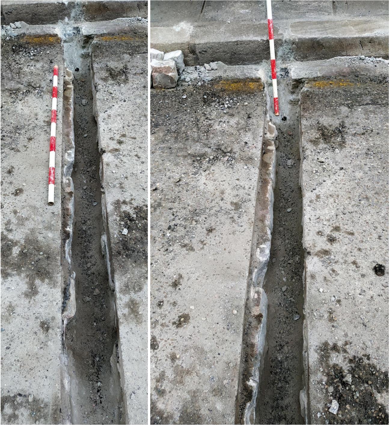
Ilustración 9: Zanja que cruza la calle
