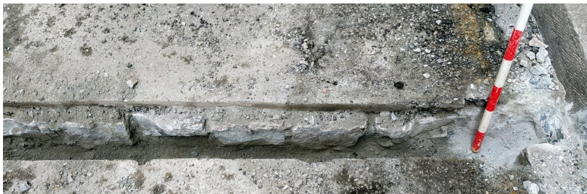
Ilustración 10: Adoquines bajo el asfalto
