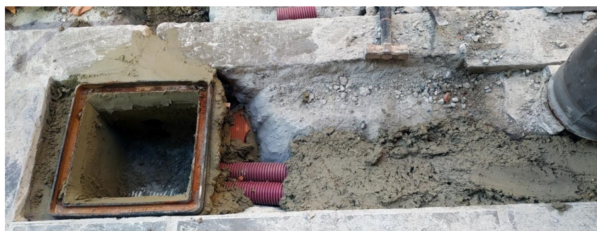
Ilustración 18: Construcción de la Arqueta entre ambas zanjas
