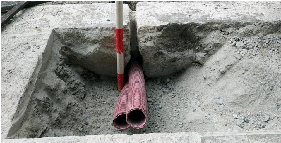
Ilustración 20: La profundidad máxima de rebaje han sido 30cm.
