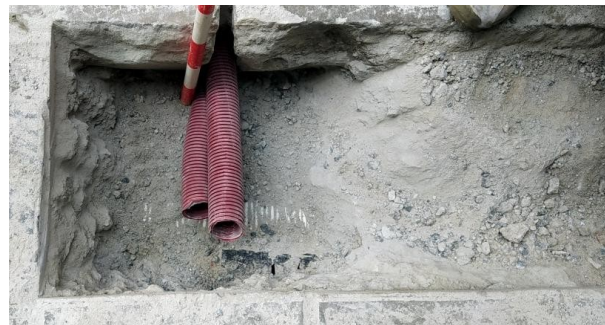
Ilustración 17: Arqueta y zanja en la acera Este.
