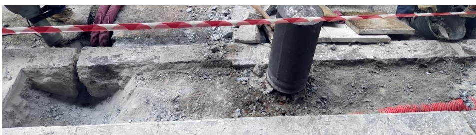
Ilustración 15: Acera Este, espacio de la arqueta, sobre servicios anteriores.
