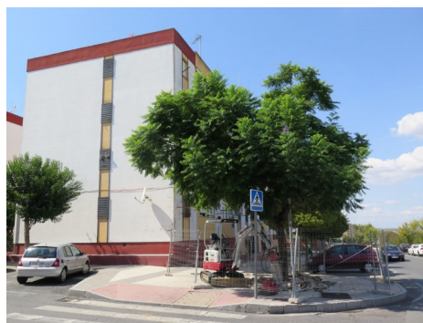
Lám 2. Inicio y situación pozo 3
