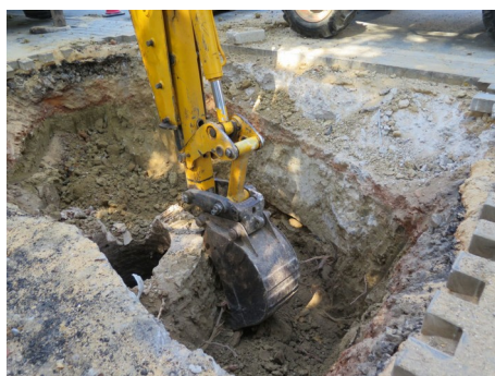
Lám. 1 proceso de excavación pozo 4
