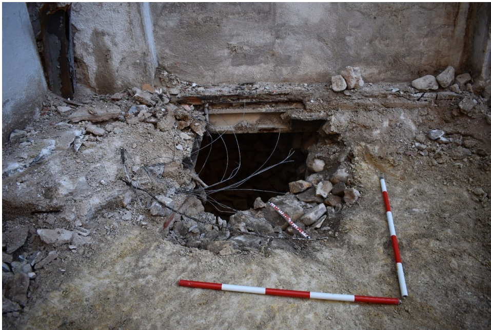
Lam. 2: Pozo US 10 y Revestimiento US 14. Dirección SE-NW.
