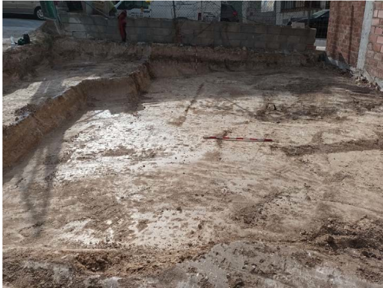
Lám. 5. Planta final. Cota de excavación.
