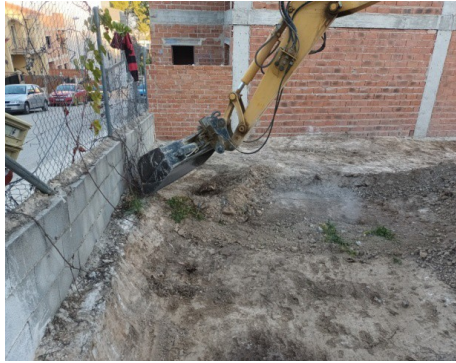
Lám. 3. Proceso de desmonte de la unidad sedimentaria 2.
