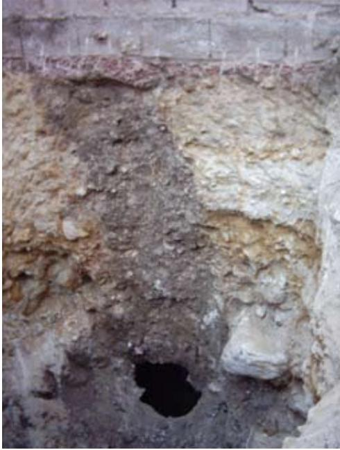
El pozo localizado en el batache N° 16, se encontraba relleno de escombros y tierra desde el nivel de la cimentación (nivel de la acera) hasta los - 2.00 metros; y desde aquí hasta los - 3.50 m. se encontraba sellado por un bloque de cemento de unos 1.50 metros de espesor. Por debajo de este hasta llegar a los - 4.30 m. se encontraba relleno de nuevo por tierra y escombros.
