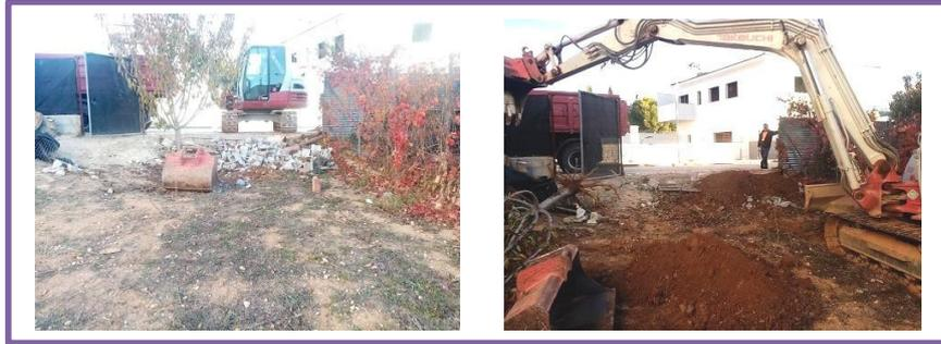
FIG. 7. ADECUACIÓN DE LA PARTE DELANTERA DEL SOLAR (ZONA SEPTENTRIONAL) PARA EL ACCESO AL INTERIOR DEL MISMO DE LOS MEDIOS MECÁNICOS NECESARIOS PARA ACOMETER EL VACIADO DE SUS DISTINTAS SUPERFICIES MEDIANTE C.A.M.T. (Fotos: Rafael Sánchez).
