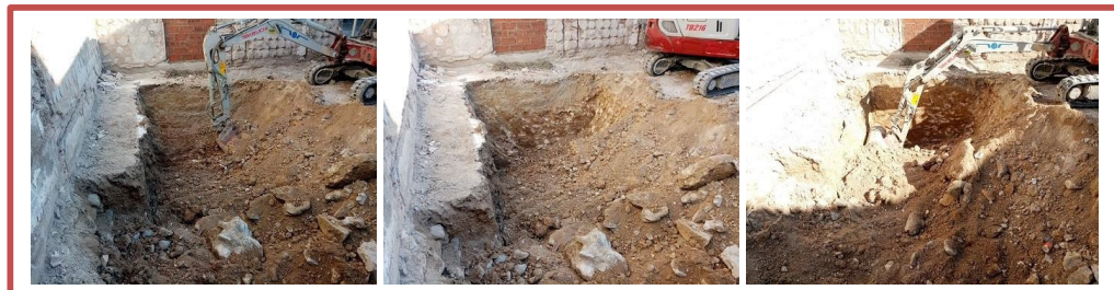
FIG. 9. VACIADO DE LA ESQUINA NORORIENTAL DEL ÁREA DESTINADA A LA CONSTRUCCIÓN DE LA PISCINA PROYECTADA: AFLORAMIENTO DE LA MATRIZ GEOLÓGICA DEL TERRENO DESDE COTAS MUY SUPERFICIALES (Fotos: Rafael Sánchez).
