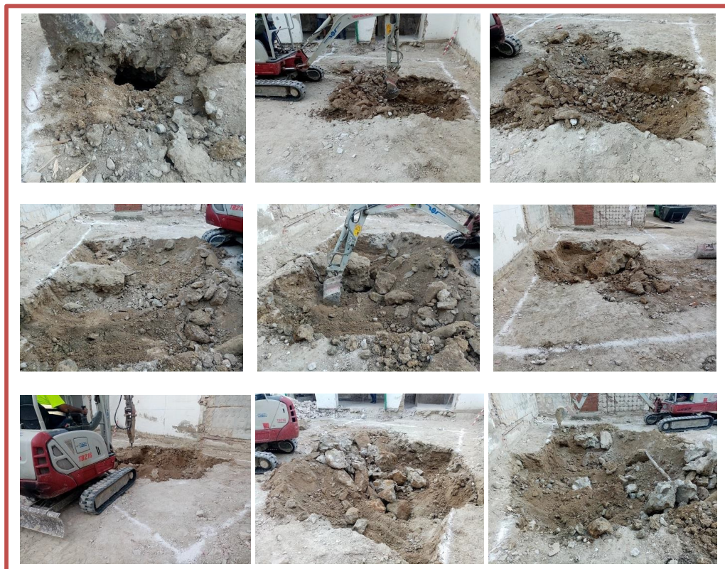
FIG. 8. INICIOS DEL VACIADO DEL ÁREA DE CONSTRUCCIÓN DE LA PISCINA PROYECTADA: CIMENTACIÓN DE HORMIGÓN, RESTOS DEL SANEAMIENTO Y RELLENOS REVUELTOS MEZCLADOS CON PIEDRAS DE UN LAVADERO EXISTENTE EN EL PATIO INTERIOR DE LA VIVIENDA (Fotos: Rafael Sánchez).
