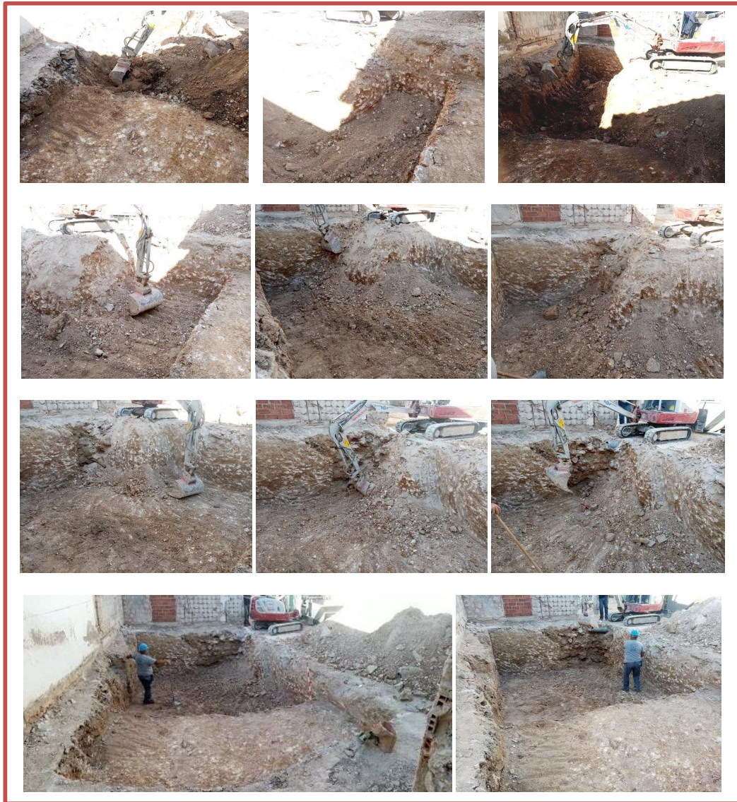
FIG. 11. VACIADO DEL RESTO DEL VASO MÁS PROFUNDO DE LA PISCINA PROYECTADA (FLANCO MÁS OCCIDENTAL): SE PUEDE OBSERVAR COMO FUIMOS ELIMINANDO LOS RESTOS DE UNA CIMENTACIÓN CONTEMPORÁNEA, EN MAMPOSTERÍA IRREGULAR DE PIEDRA CALIZA, QUE FORMABA ESQUINA EN EL CENTRO DEL PERFIL MERIDIONAL DEL ÁREA DE VACIADO (Fotos: Rafael Sánchez).
