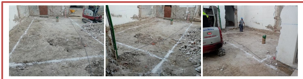
FIG. 7. DELIMITACIÓN DEL ÁREA DESTINADA A LA CONSTRUCCIÓN DE LA PISCINA PROYECTADA EN EL PATIO INTERIOR DE LA VIVIENDA A REFORMAR DONDE SE IBA A EJECUTAR NUESTRO C.A.M.T. (Fotos: Rafael Sánchez).
