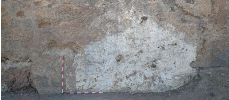
Lámina 9. Encalado en el Tramo 1 de la muralla
