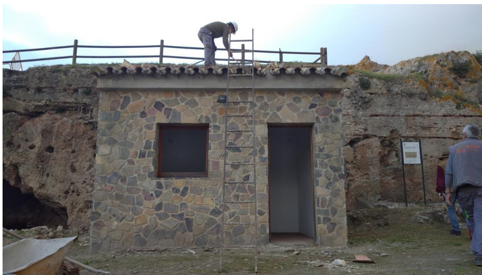
Lámina 1. Inicio de los trabajos.
