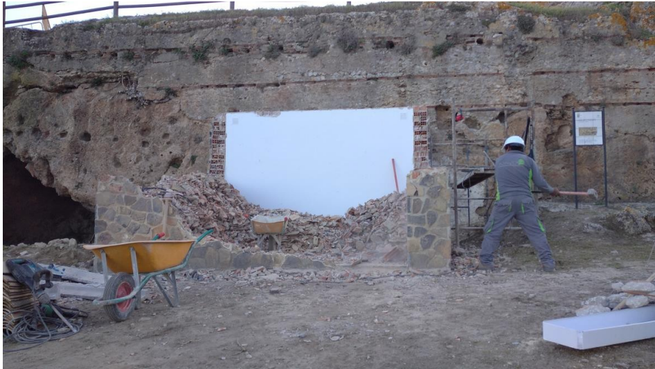
Lámina 7. Desarrollo de la demolición.
