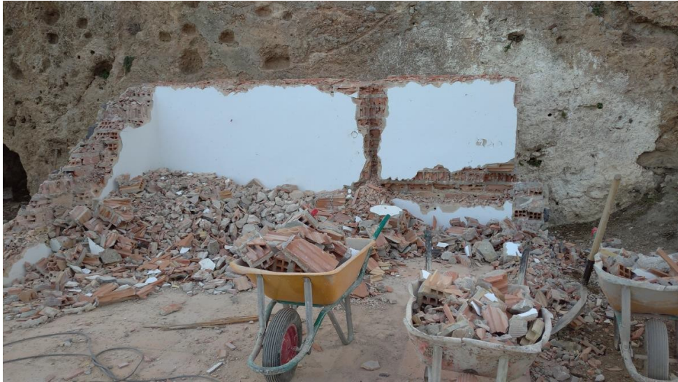
Lámina 8. Desarrollo de la demolición y desescombro
