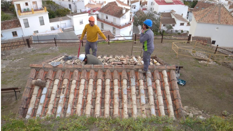
Lámina 2. Retirada de la cubierta.
