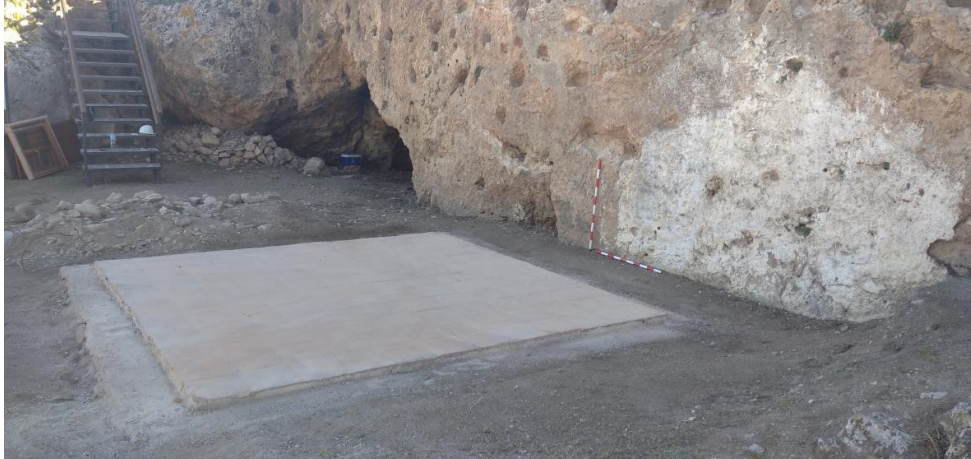
Lámina 12. Tramo 1 de la muralla con la caseta eliminada.
