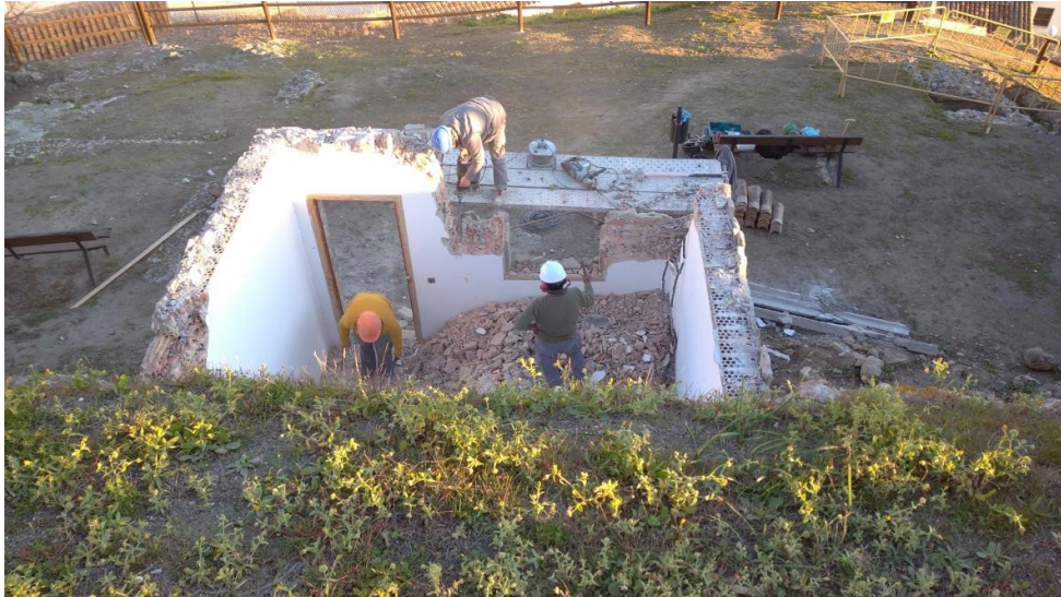
Lámina 6. Desarrollo de la demolición.
