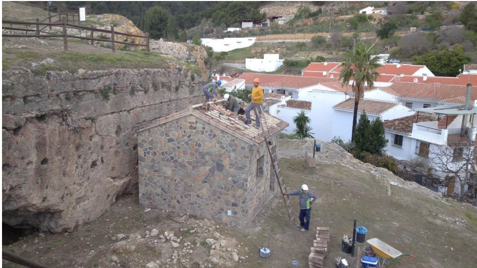
Lámina 3. Trabajos de retirada de la cubierta.
