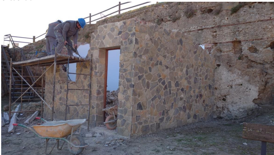
Lámina 5. Inicio de los trabajos de demolición
