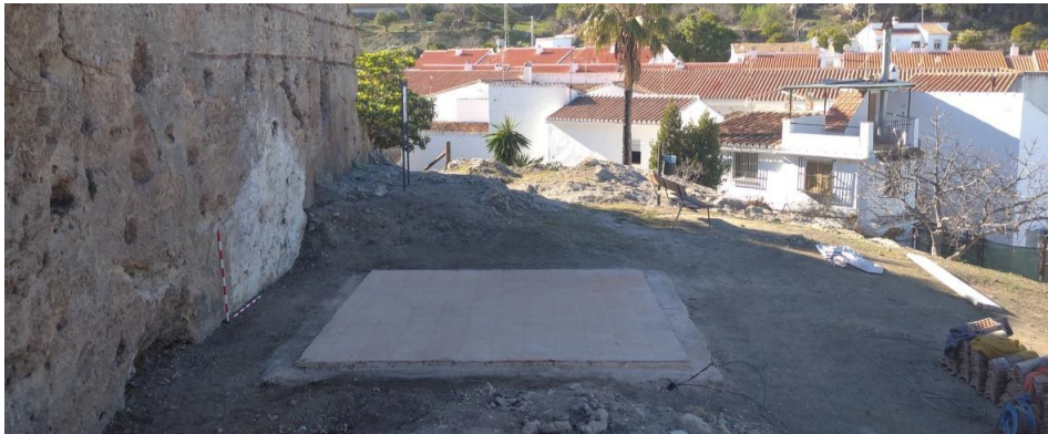
Lámina 10. Cimentación de la caseta
