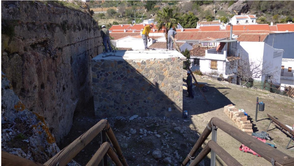
Lámina 4. Finalización de la retirada de la cubierta.
